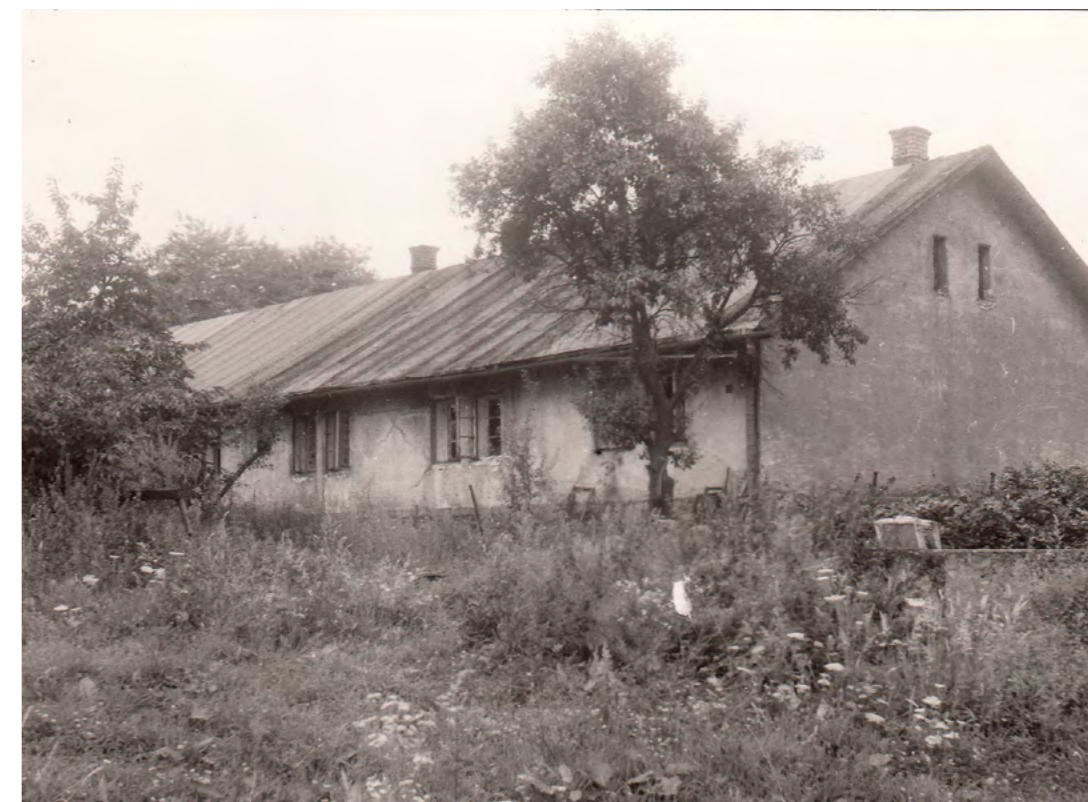
→ Dům čp. 1343 během demoličního řízení (SOKA Karviná)
