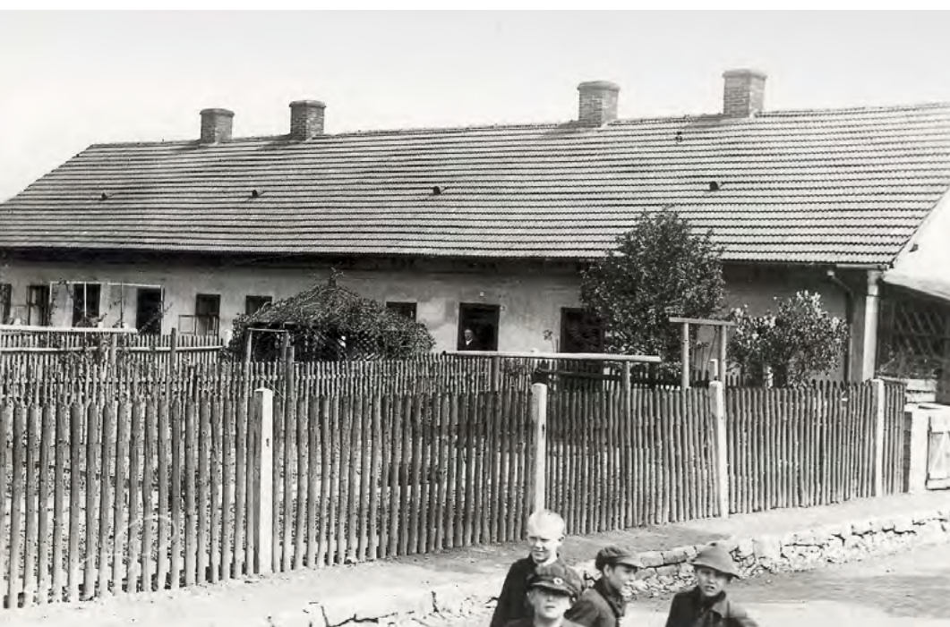
← Fotografie osmibytového domu v kolonii Sovinec z meziválečného období (SOKA Karviná)
