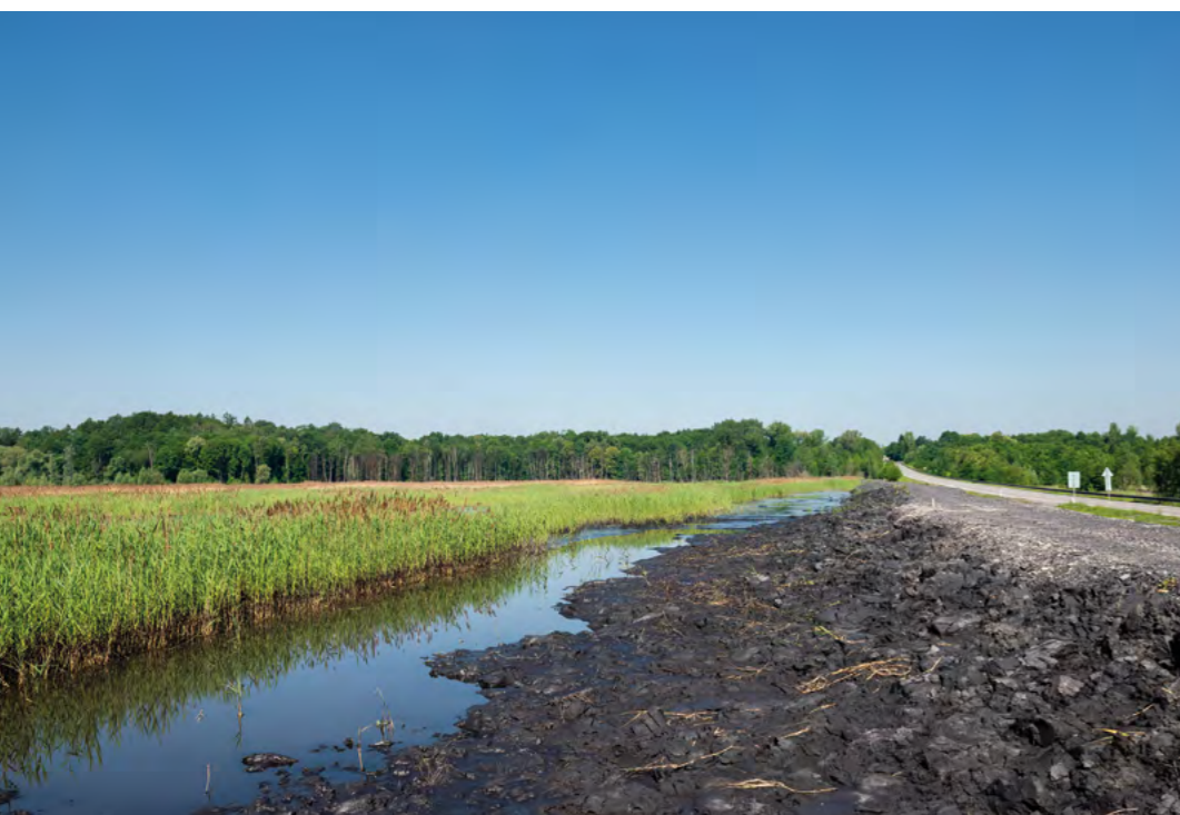
← Odkaliště dolu Karviná, závodu ČSA; v těchto místech stávala kolonie Na Hranicích (foto Miroslav Pawelek, 2018)
