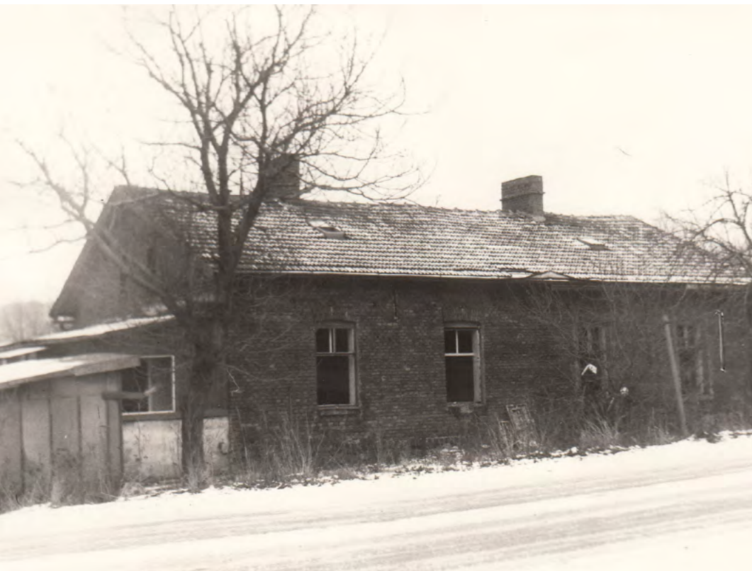
← Dům čp. 923 v Červené kolonii, stav před demolicí, foto z února 1989 (SOkA Karviná)
