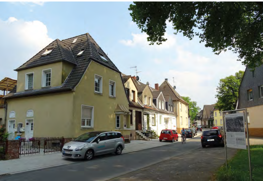
← Domy v bývalého hornické kolonii Gottfried-Wilhelm v Essenu navržené architektem Oskarem Schwerem (foto Agáta Kravčíková, 2016)
