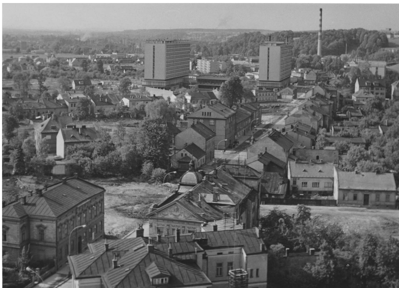
(Obr. 7) Fotografie Šlapetova domu, r. 1967, foto: M. Klega (SOka F-M)
