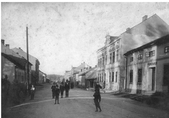
(Obr. 17) Pohled na dům č. 9 a č. 8.
