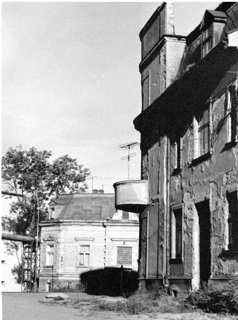
Obr. 15 - Pohled na zadní průčelí obchodního domu, domu čp. 27, v pozadí fasáda pilnikárny
