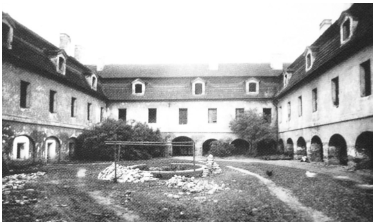
Nádvoří šenovského zámku před demolicí
