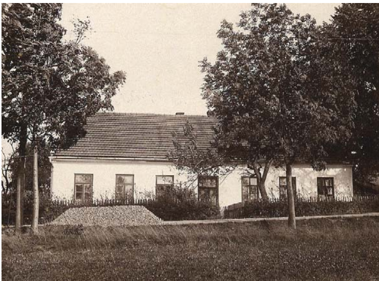
Původní podoba školy „pod Radhoštěm“ – po požáru v roce 1930 byla přestavěna
