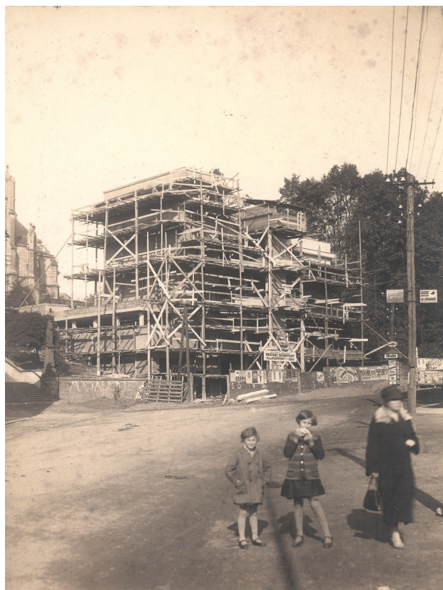
Stavba nové budovy Městské spořitelny v Orlové
