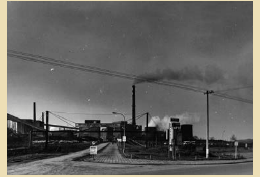
Elektrárna u Dolu ČSA, bývalá elektrárna dolu Jan.
