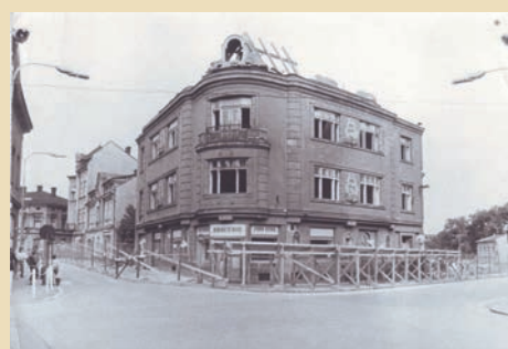
Demolice domů na rohu náměstí a Hrnčířské ulice a na rohu Fryštátské ulice a K. Šliwky v letech 1969–1973.
