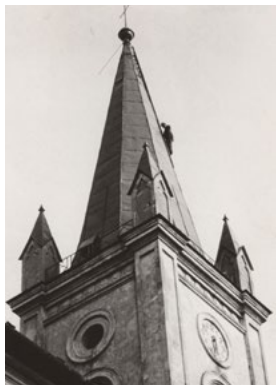
! Opravy střechy kostelní věže, druhá polovina 40. let 20. století (zdroj: SOkA Karviná)
