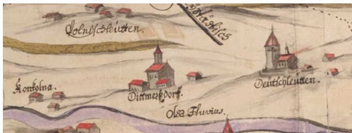
! Výřez z mapy nížinné části Těšínského Slezska z druhé poloviny 17. století, na které je drobnou vedutou znázorněno pravděpodobně nejstarší vyobrazení původního dřevěného kostela v Dětmarovicích (zdroj: Zemský archiv v Opavě)
