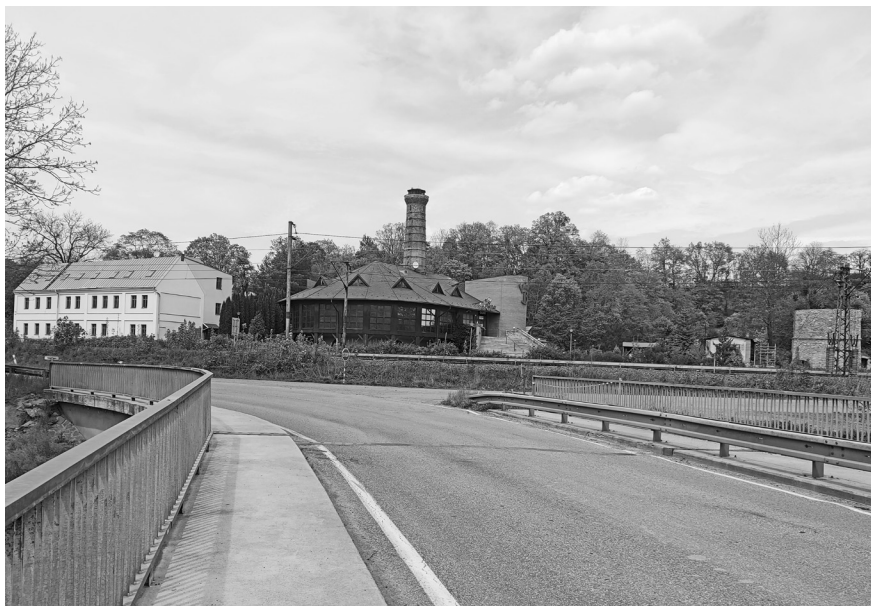
Pohled od Bečvy na objekty bývalé firmy, z kruhové pece je dnes restaurace, z administrativní budovy hotel. Foto E. Slováková
