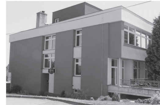
Kulturní zařízení obce Rakov vystavěné na místě hostince čp. 34. Internetové stránky obce Rakov
