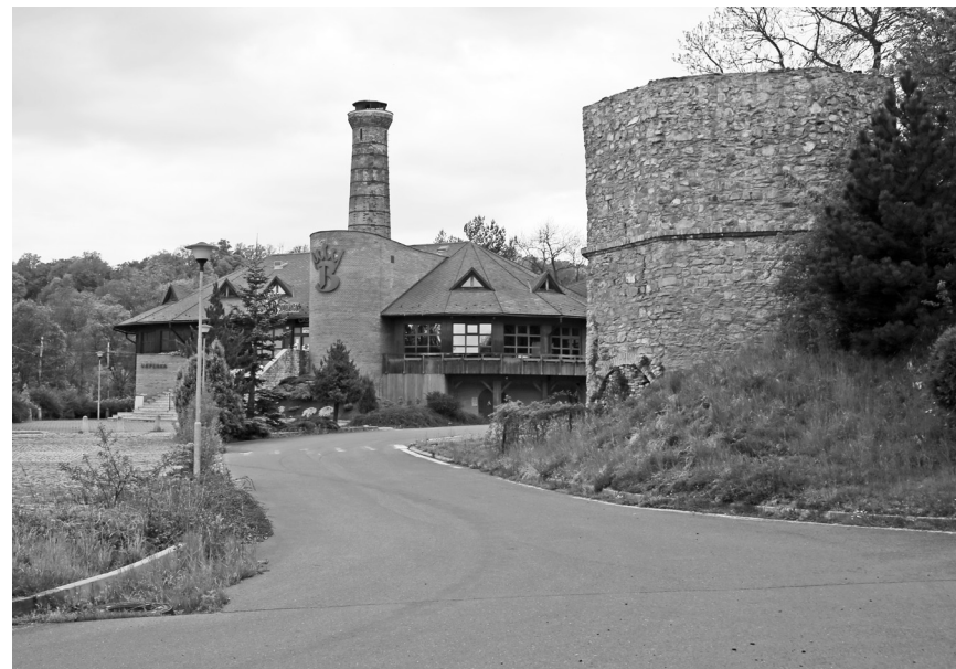
Kruhová pec po rekonstrukci na restauraci, vpravo torzo vysoké pece. Foto E. Slováková
