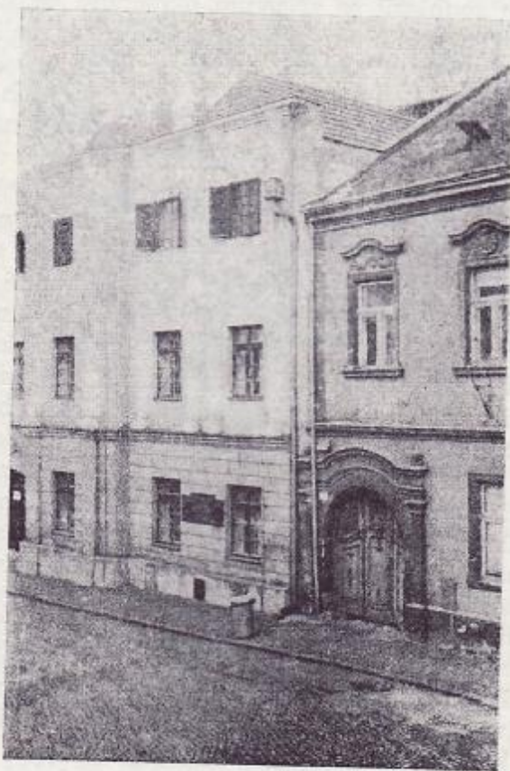
Depozitář SOKA v Pířerově, Horní náměstí 10
