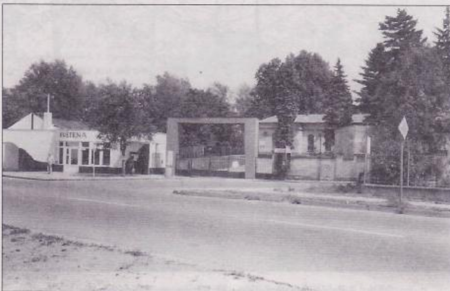
Obr. 2 Vchod do staré části hřbitova v ul. 9. května
