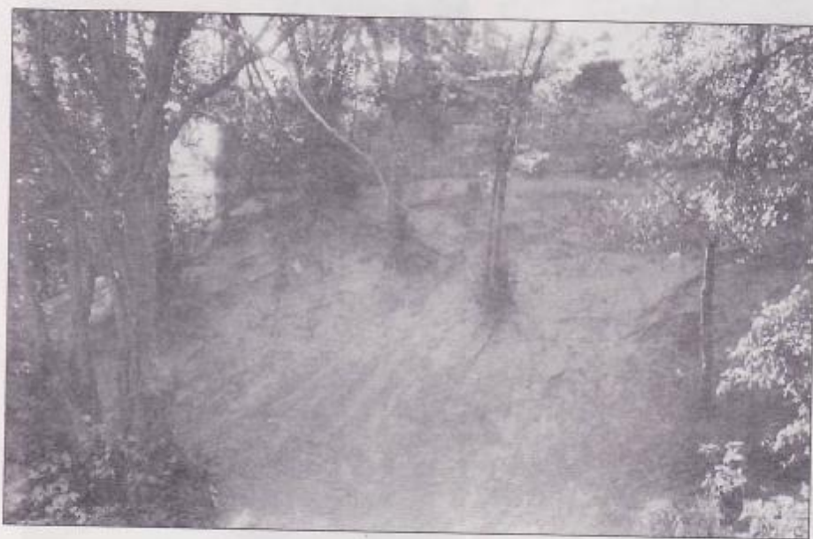
Obr. 17 Narušené svahy za hřbitovní zdí v Předmostí
