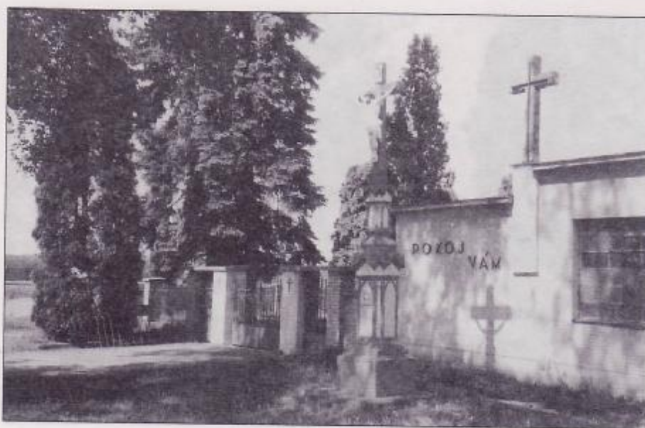
Obr. 25 Vchod do hřbitova v Přerově-Henčlově
