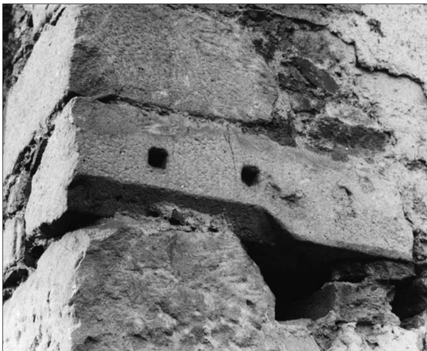
Detail kamenného pozdně gotického ostění v jihovýchodním nároží objektu. Foto Markéta Ondrušková.
