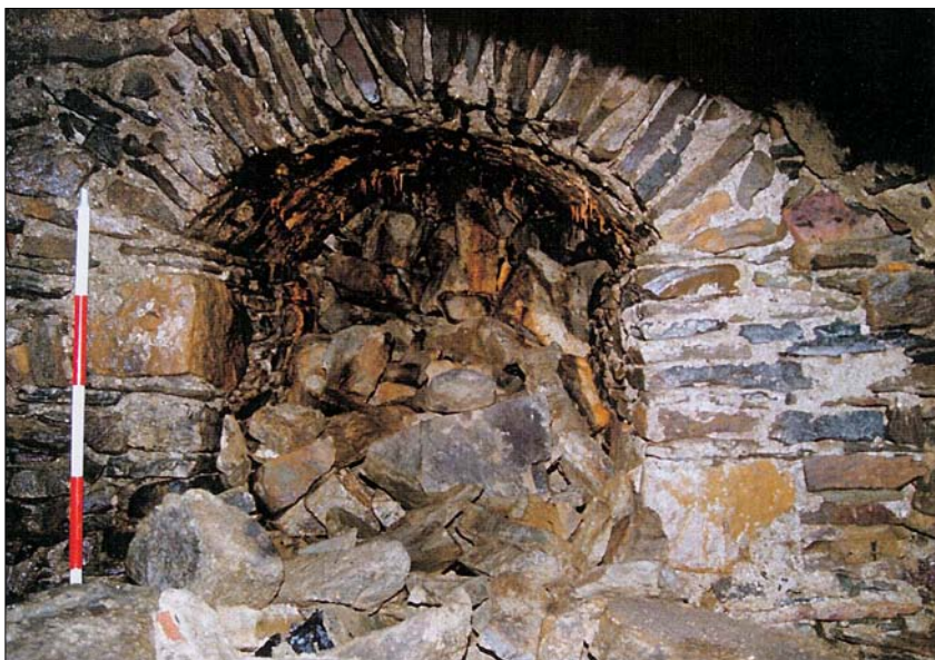
Suterénní prostor v nádvoří, zásyp otvoru (patrně průchodu) v severozápadní obvodové zdi. Při čelním pohledu se vlevo od otvoru nacházela destrukce zdiva a místo „propadu“. Foto autorka článku.
