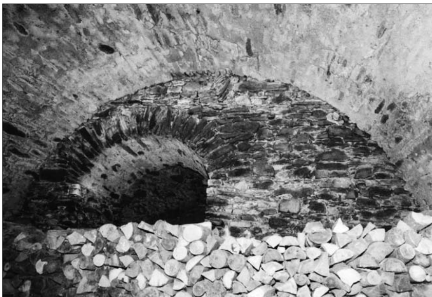
Pohled na valenou klenbu čtvrtého sklepa pod jižním křídlem (ve směru od západu) a severní obvodovou zeď s klenutým otvorem, snad původním vstupem do renesančních sklepů pod jižním křídlem, za nímž je zásyp s destruovaným lomovým zdivem. Foto Markéta Ondrušková.
