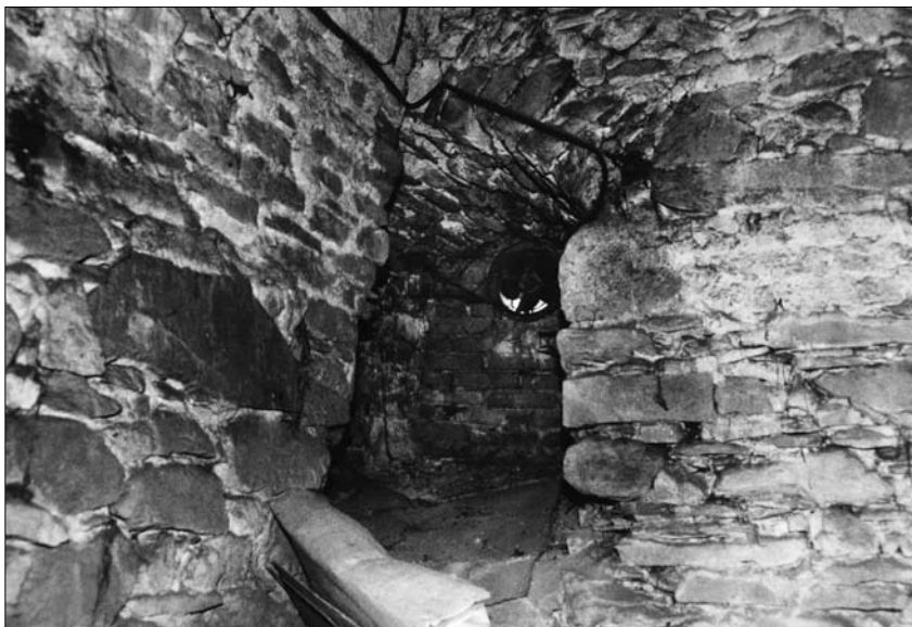
Zazděný otvor původní střílny tvrze ze 14. století v jižní obvodové zdi jižního křídla v prostoru druhého sklepa (ve směru od západu), otvor je zčásti překryt renesanční příčnou zdí. Foto Markéta Ondrušková.
