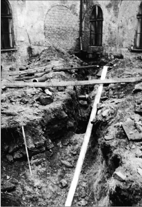
Pohled do jihovýchodního nároží nádvoří, trám se spuštěným provazem v místě propadu“ do suterénního prostoru. Foto autorka článku.
