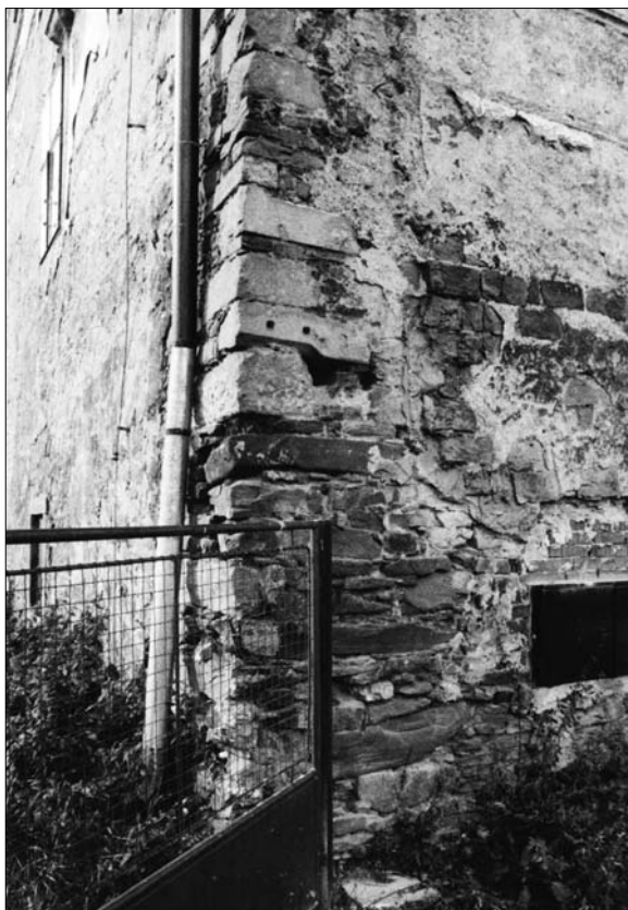
Kamenné pozdně gotické články (většinou fragmenty ostění s okosením ukončeným šikmou trojúhelníkovou ploškou), použité druhotně jako armování jihovýchodního nároží. Foto Markéta Ondrušková.
