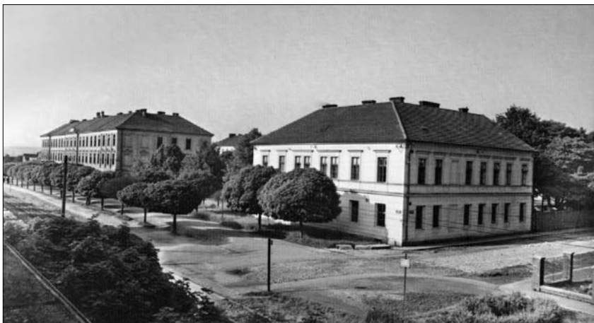
Kasárna ve Vysokém Mýtě.
