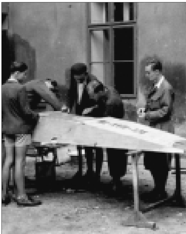
Obr. 4. Oprava gondoly u Dvořáčků, r. 1945.
