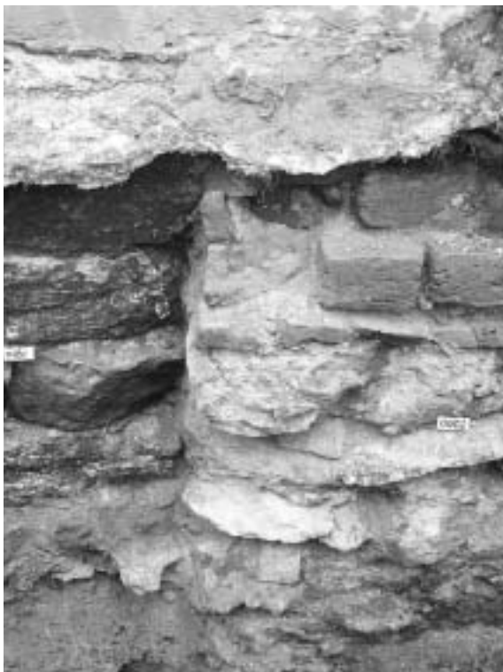
Obr. č. 4 Stavební spára přístavby kostela. Foto Zd. Schenk
