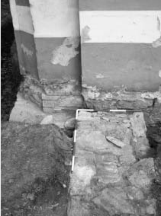
Obr. č. 8 Základy původní sakristie. Foto Zd. Schenk
