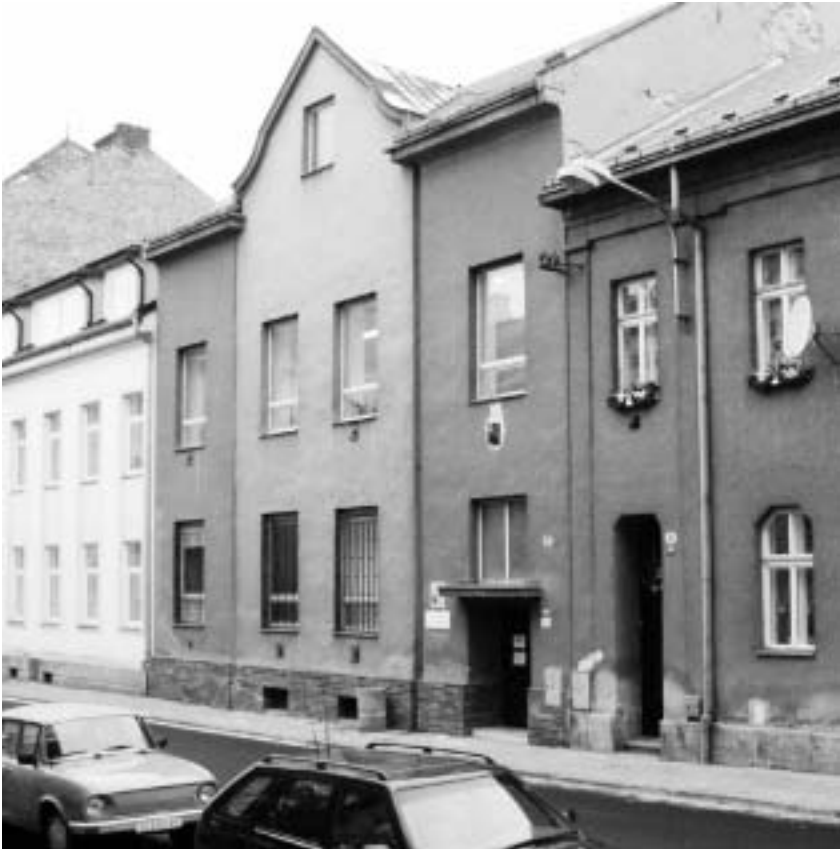
Budova bývalého národně sociálního domu v ulici Boženy Němcové (foto archiv autora)
