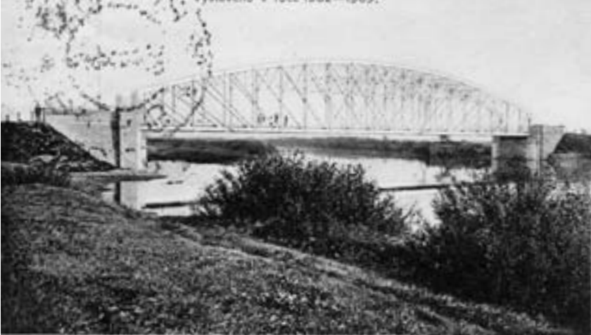
Most v Kojetíně, 1903. Sokromá sbírka
