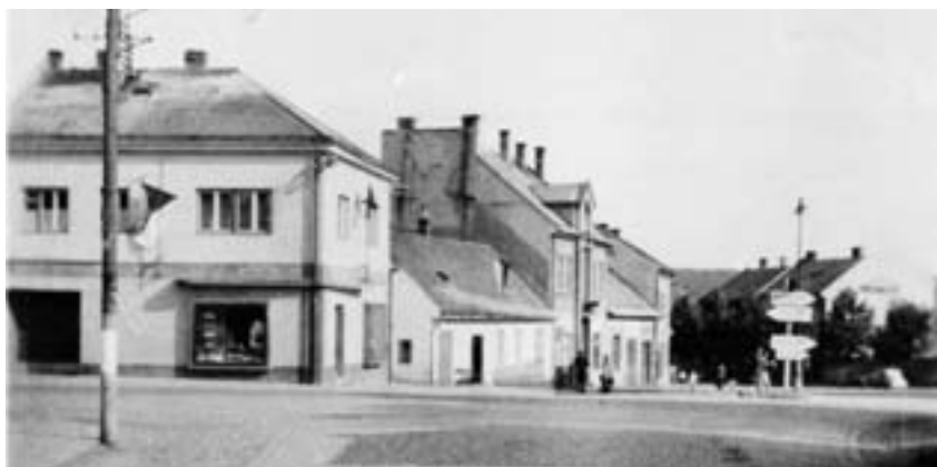
Pohled z ulice Smetanovy do ulice Novosadská
