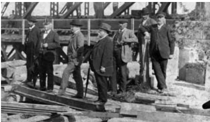
Ludvík Uhlíř, první zleva, na stavbě mostu u Kojetína, 1902. Soukromá sbírka
