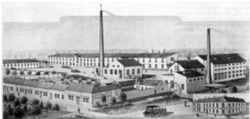
Tovární veduta firmy T. Hrubá, 1933. SOkA Přerov
