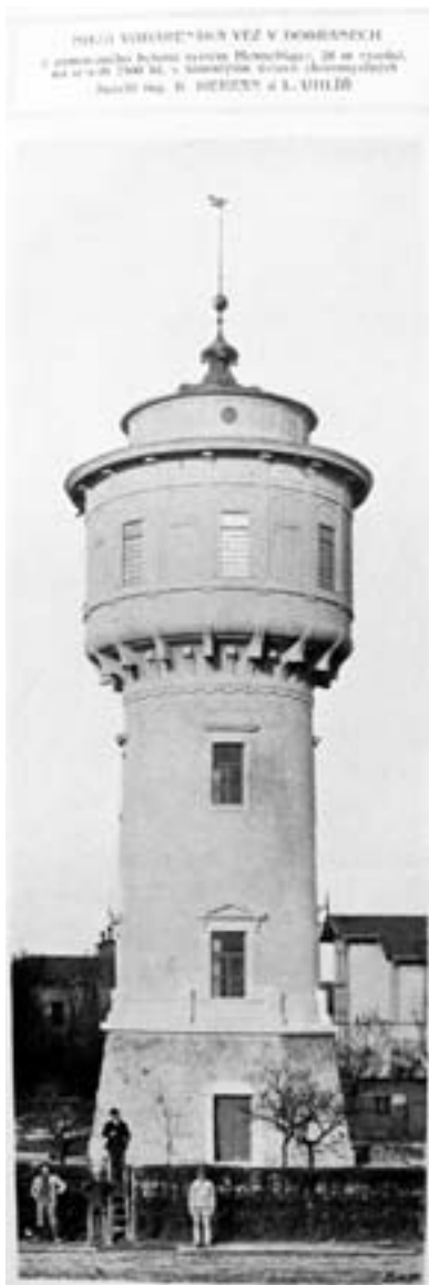
Vodárenská věž v Dobrušce v časopisu Český svět 1907–1908
