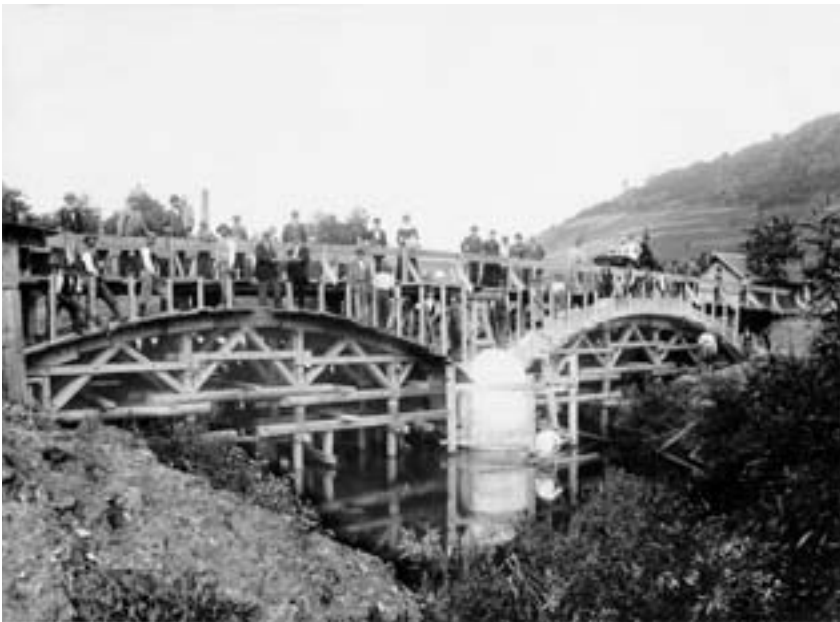
Stavba mostu v Lanšperku, 1900. SOkA Kolín
