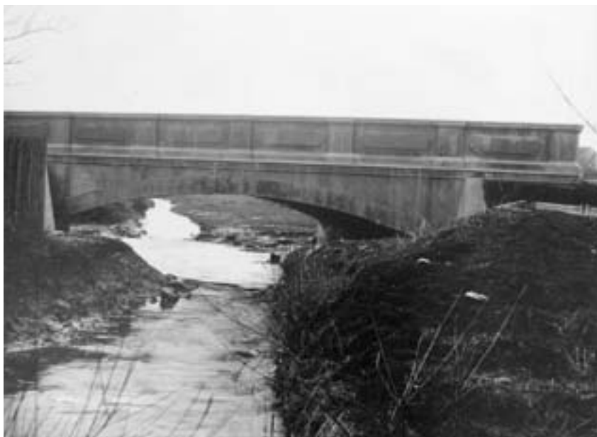
Dokončený most ve Vysokém Mýtě. SOkA Kolín
