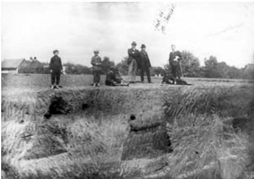
Obr. 7. Odkop zemin v trati Hejnice a Dvorská v roce 1921. Foto J. Tomčík. SOKA Přerov
