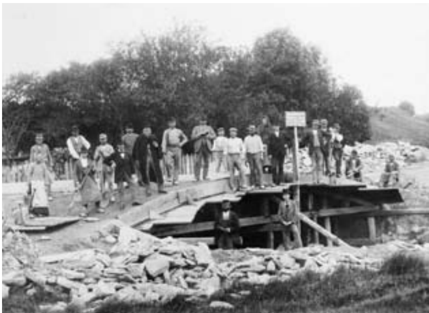
Stavba mostu ve Vysokém Mýtě. SOKA Kolín
