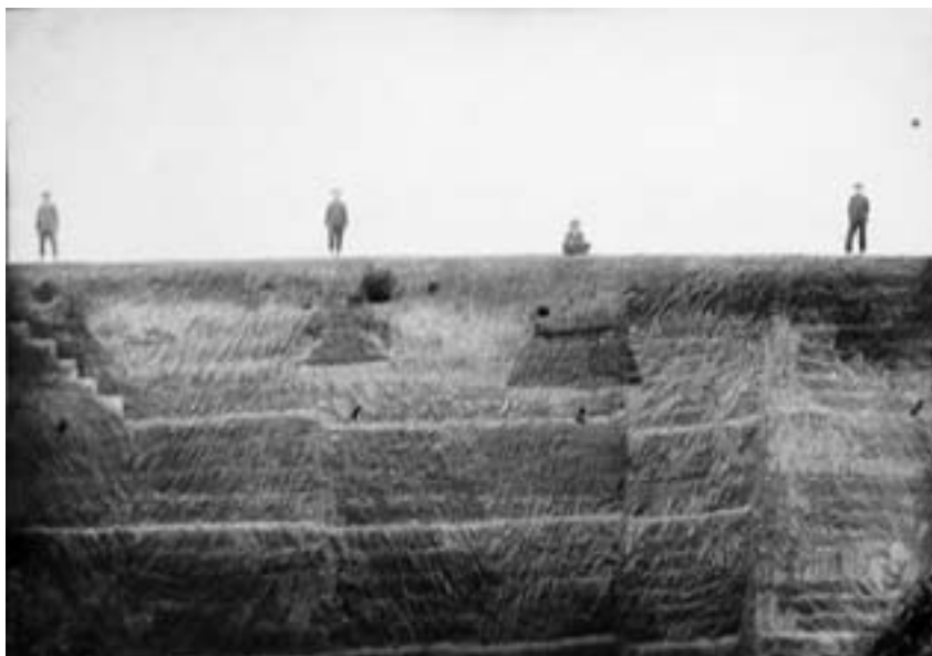
Obr. 6. Odkop zemin v trati Hejnice a Dvorská v roce 1921. Foto J. Tomčík. SOKA Přerov
