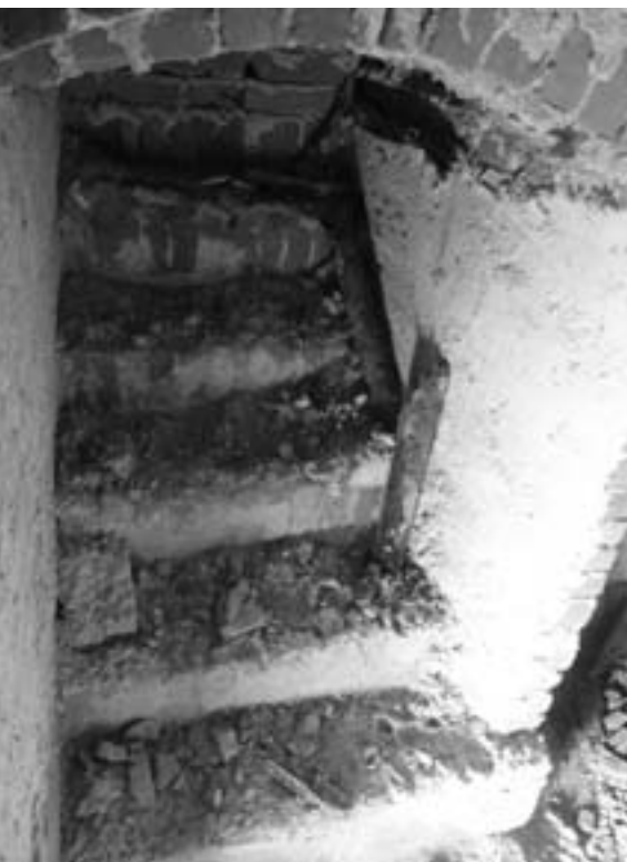
Obr. 8. Pohled na přeložené boční schodiště, po kterém se sestupovalo do krypty pod presbyteriem
