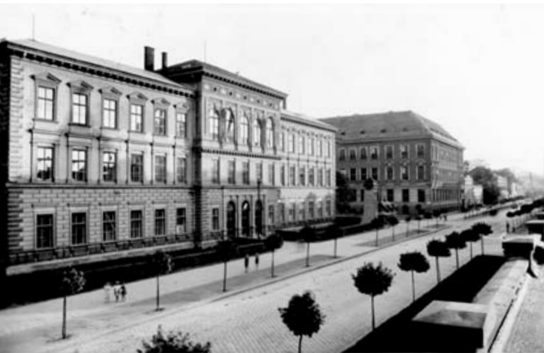
Budova přerovského gymnázia. SOKA Přerov
