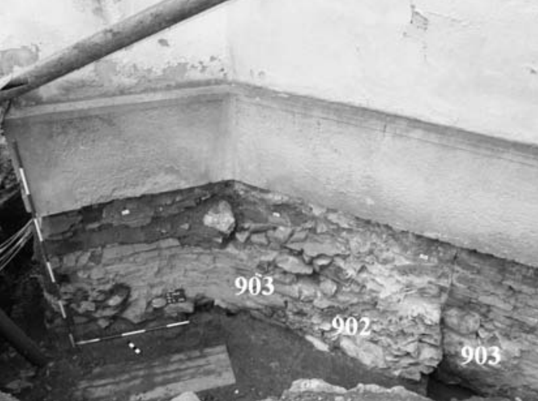
Obr. 2. Pohled na základ jihovýchodního opěráku a východní linii základů (903) kaple Zvěstování Panny Marie vystavěné po roce 1406, kterou byl přezděn základ (902) původní stavby kostela
