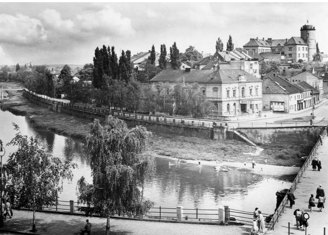
Pohled na náměstí Na Marku s tělocvičnou Sokola, po roce 1945. SOka Písek
