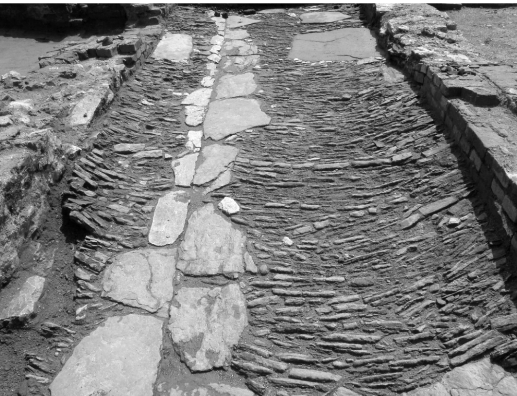
Obr. 9 Přerov. Na Marku. Pohled na renesanční dlážděnou cestu ze severní strany od řeky Bečvy (foto. Z. Schenk)
