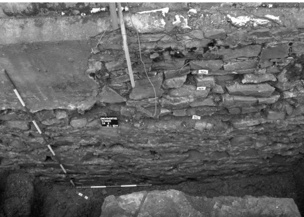
Obr. 9. Pohled od severovýchodu na obnažené základové zdivo zvonice v místě, kde se v minulosti nacházel vstup do krypty. Foto. Z. Schenk, 2014
