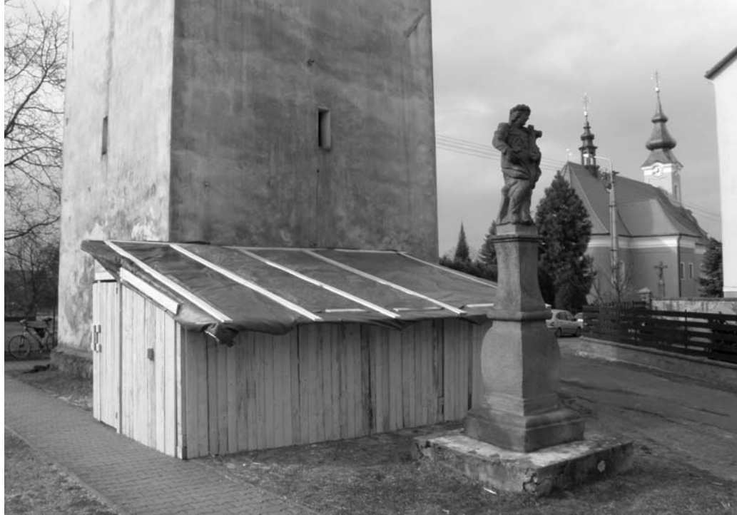
Obr. 10. Pohled od východu na provizorní dřevěný přístřešek umístěný nad zjišťovací sondou při severozápadní straně zvonice. V pozadí bývalý bratrský sbor přestavěný na kostel sv. Havla. Foto. Z. Schenk
