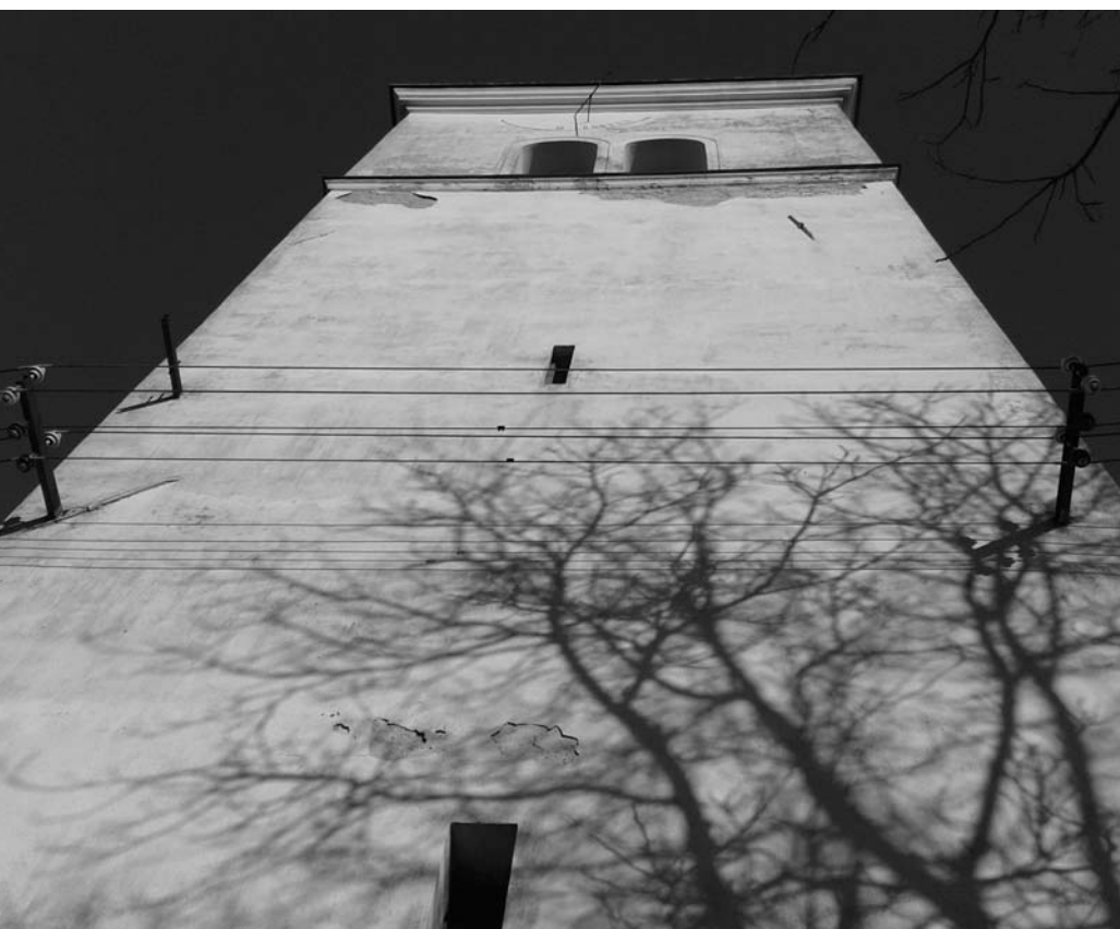
Obr. 4. Pohled od jihozápadu na zvonové patro zvonice. Foto: Z. Schenk, 2014
