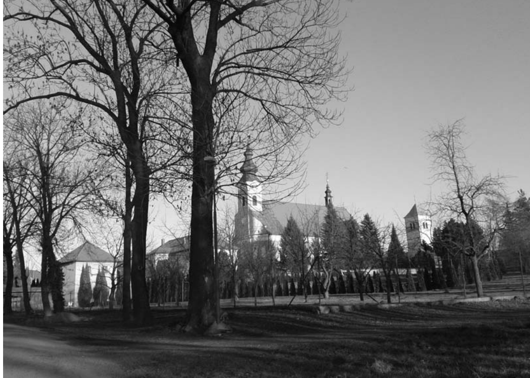
Obr. 1. Celkový pohled od jihozápadu z pravého břehu říčky Moščenky na kostel sv. Havla — bývalý bratrský sbor a zvonici. Foto: Z. Schenk, 2014
