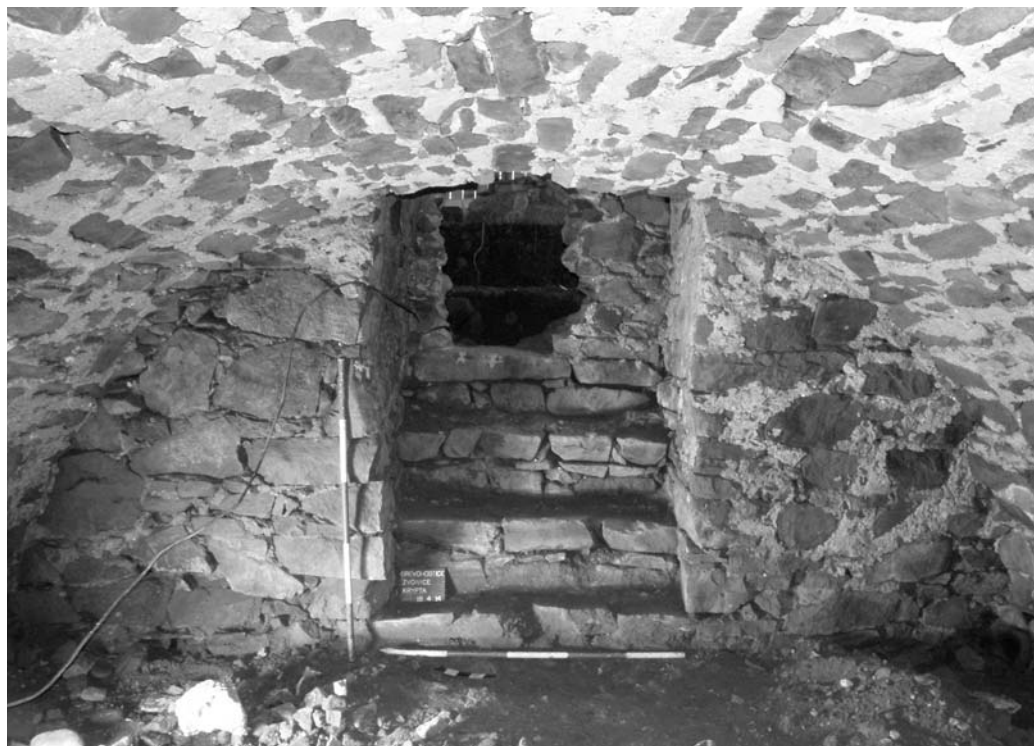
Obr. 14. Severovýchodní stěna krypty se vstupním schodištěm. Otvor v zadržce vchodu. Foto. Z. Schenk, 2014
