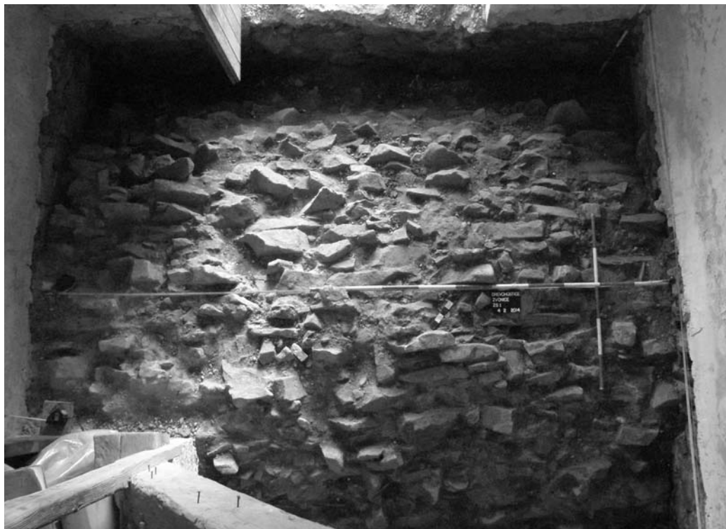
Obr. 11. Vypreparovaná klenba kryty odkrytá pod podlahou v interiéru zvonice. Foto. Z. Schenk, 2014
