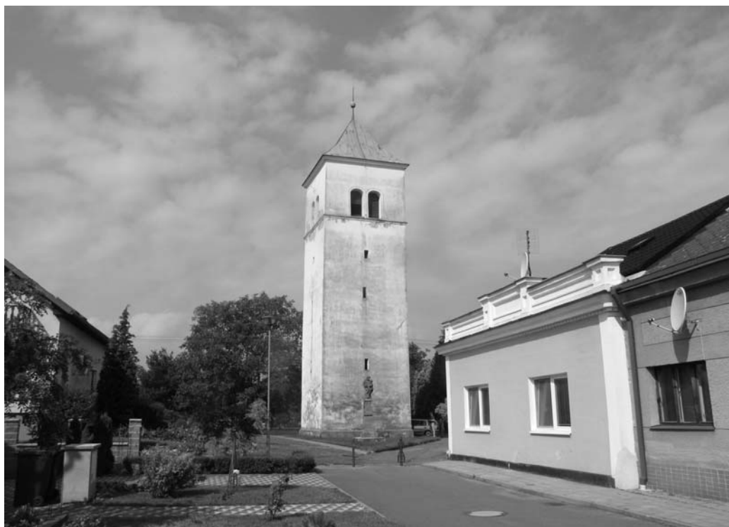
Obr. 2. Celkový pohled na objekt zvonice od východu. Foto: Z. Schenk, 2014
