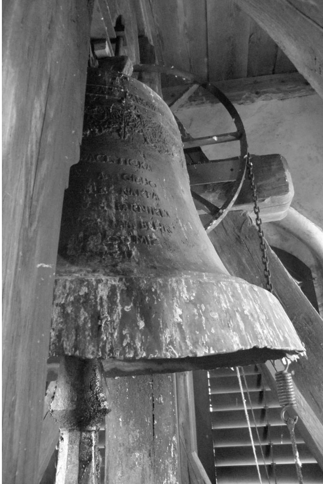
Obr. 5. Detail zvonové stolice a zvonu. Foto: Z. Schenk, 2014
