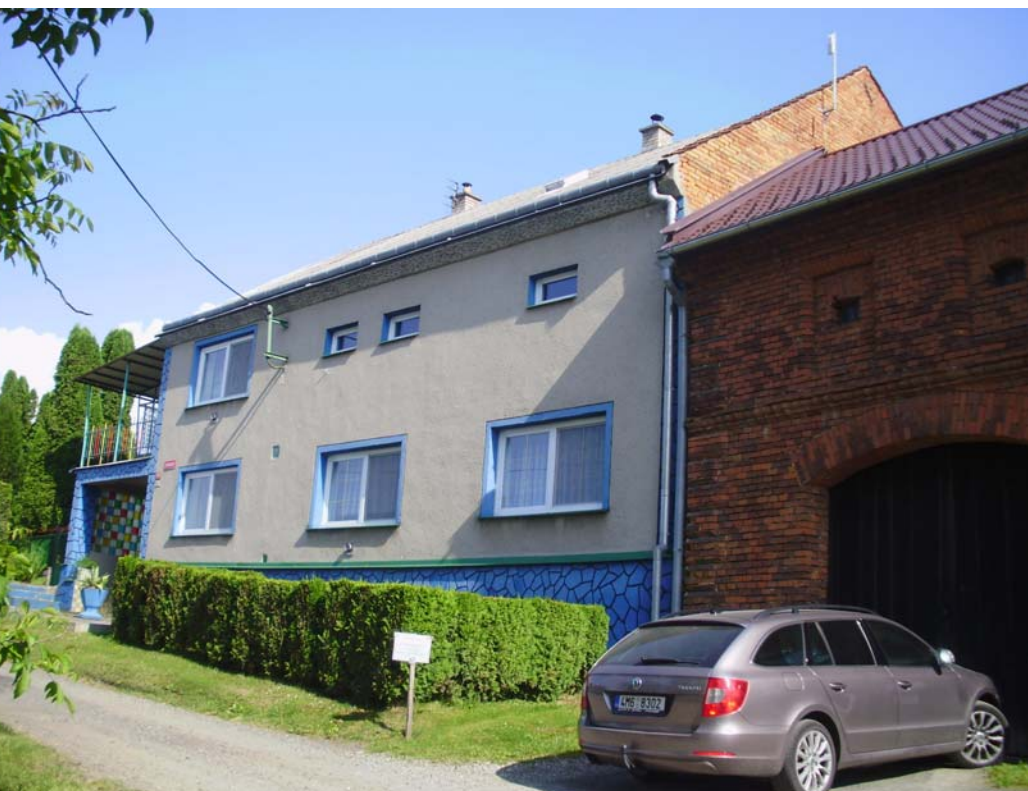
Dnešní dům čp. 18 v Újezdci. Foto Petr Jirák
