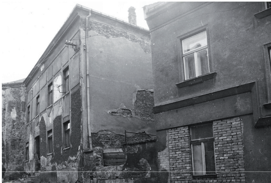
Zazdívka původního výkladce v levé části parteru domu, 1967
