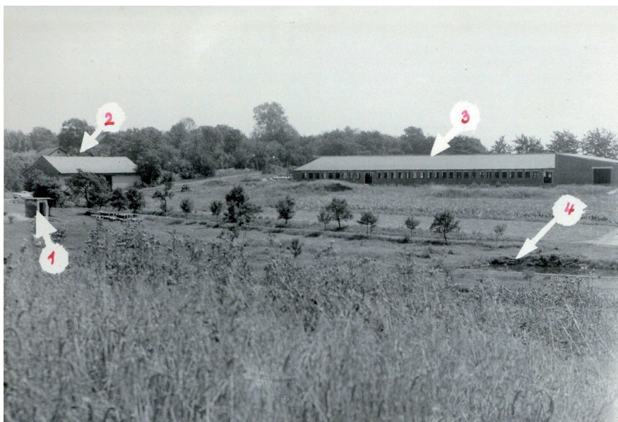
Celkový pohled na místo, kde došlo k tragédii. SOKA Přerov
