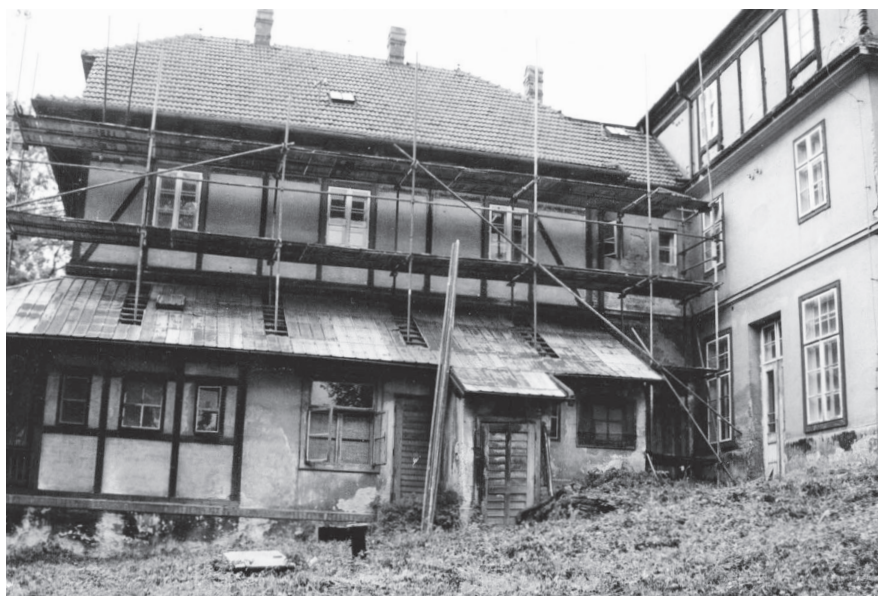
Stav objektu Zory při započetí rekonstrukce
