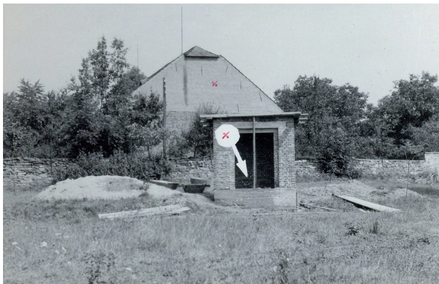
Pohled na rozestavěnou vodárnu a stodolu V. Pavelky. SOkA Přerov
