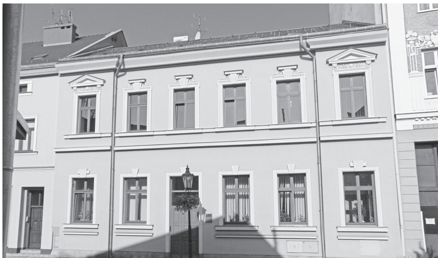
Budova školy v Janáčkově ulici. SOkA Přerov
