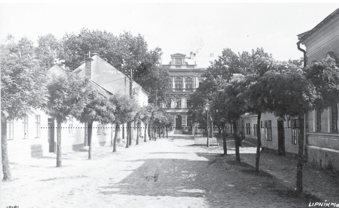
Pohled dnešní Palackého ulici ke gymnáziu, vpravo lampa a za ní studna, za níž se katovna nacházela
