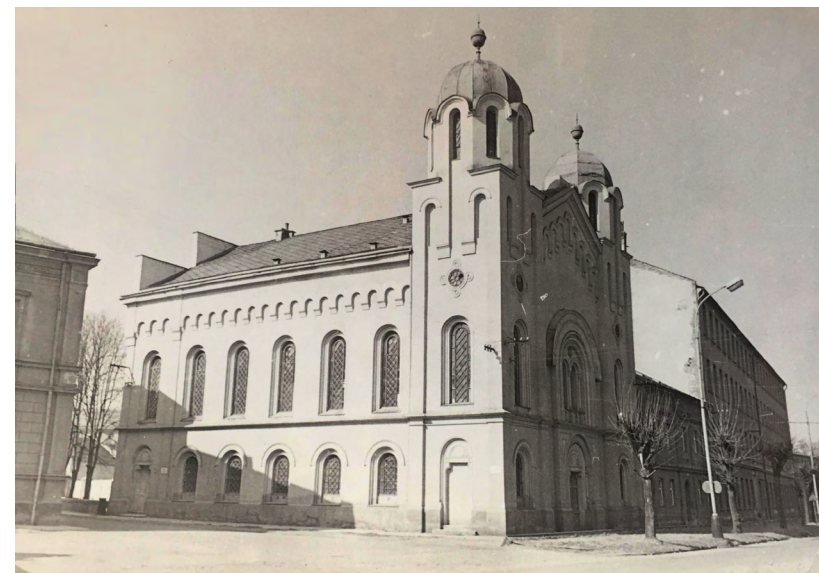
– Krnovská synagoga po opravě fasády v roce 1967. / SOKA Bruntál, fond: Státní okresní archiv Bruntál, inv. č. 86.
