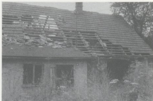
Louky nad Olší Odhalená konstrukce střechy domu čp. 181 Archív Muzea Těšínska
