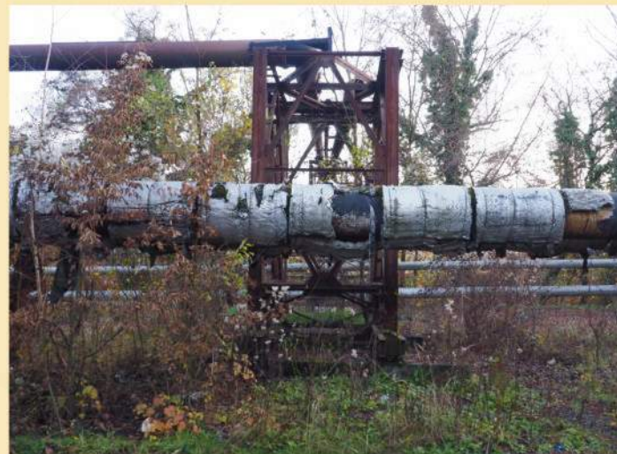
Potrubí flotačních hlušin a vratné vody táhnoucí se přes celý park v jeho vrchní části (Foto Erika Schweserová, rok 2021)
