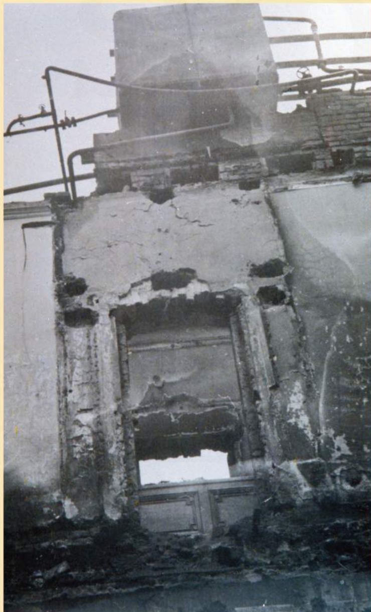
Rezervoár, jež byl pravděpodobně součástí vodovodních rozvodů (Foto z pozůstalosti F. Sikory)
