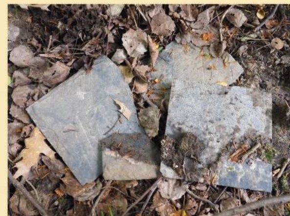
Nález břidlicové krytiny ze střechy kaple (Foto Erika Schweserová, rok 2022)
