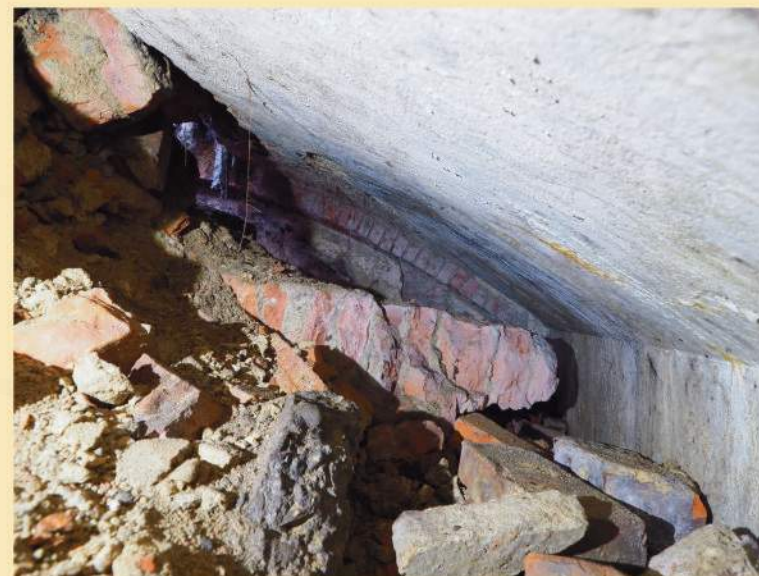
Část krypty se zřetelnou stropní klenbou (Foto z archivu Operativní skupiny Ka2, rok 2022)
