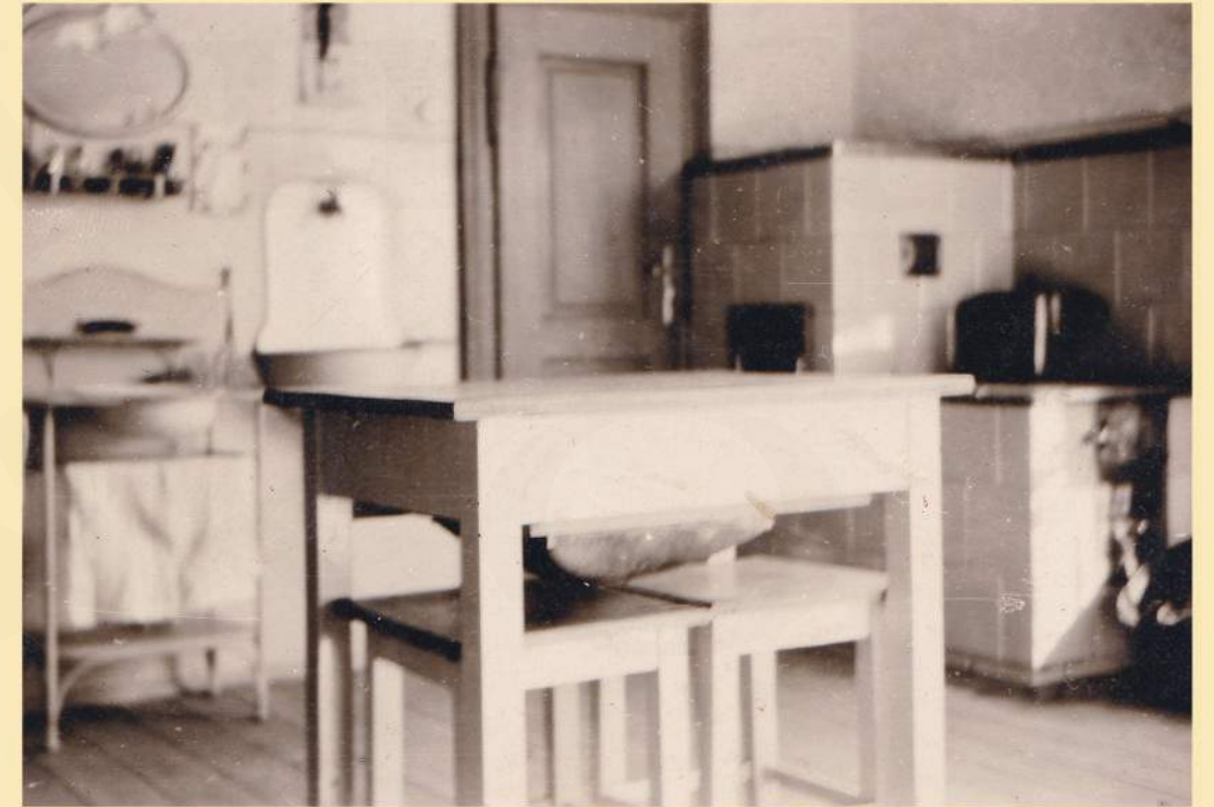
Část interiéru bytu, jež byl součástí zámecké kočárovny (Foto z rodinné sbírky Heleny Lukoszové)
