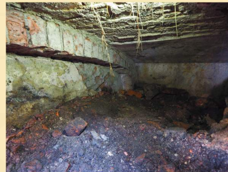
Část stropní klenby (Foto z archivu Operativní skupiny Ka2, rok 2022)
