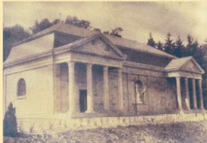
Celkový pohled na rodovou hrobku v Solci krátce po její výstavbě (Foto ze soukromé sbírky Ing. Stanislawa Kolka)
