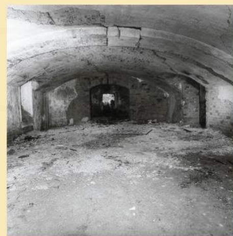
Interiér krypty se silně narušenou stropní klenbou (Foto HBZS Ostrava, Magistrát města Karviná)
