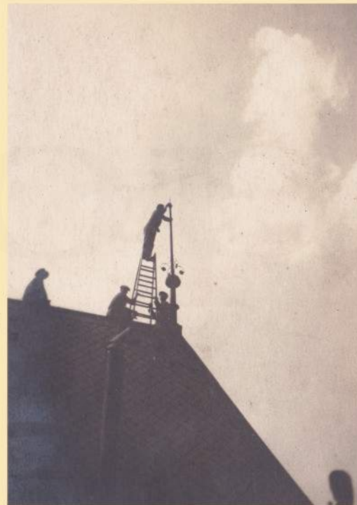
Kontrola hromosvodu. Elektroúdržbář Leo Kula na střeše zámku Solca s pomocníky Duškem, Sojkou a Otřanským. Rok 1939 (Foto z rodinné sbírky Eduarda Kuly)
