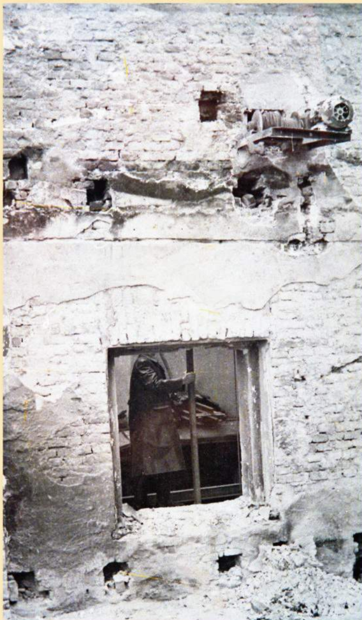
Snímek zachycující okénko a strojovnu malého výtahu, který pravděpodobně sloužil k přepravě pokrmů nebo také prádla a jiného drobnějšího nákladu (Foto z pozůstalosti F. Sikory)
