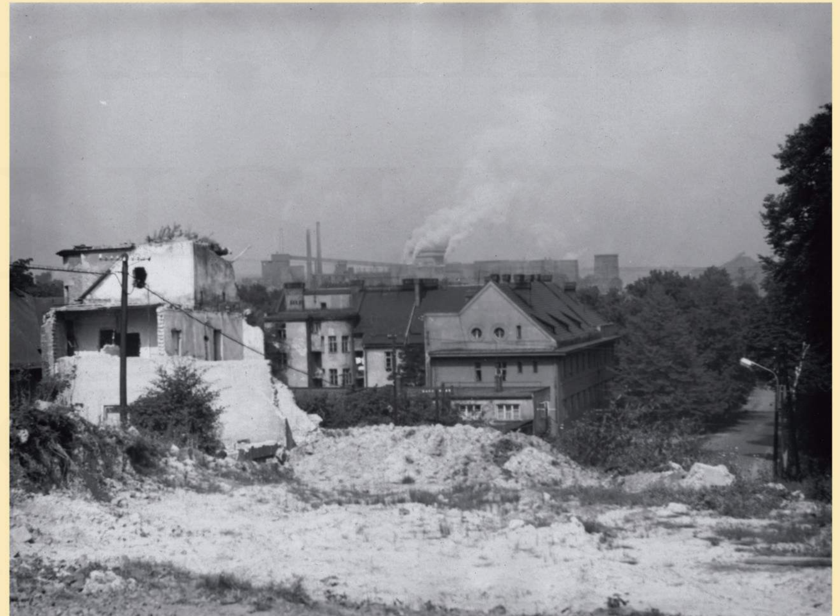
Pohled ze Soleckého kopce na probíhající demolici domu č. p. 1613. V pozadí důl ČSA. Konec 50. let 20. st. (Foto Ing. Jan Válek)
