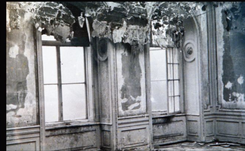
Místnost s půlkruhovými okny. Na fotografii lze spatřit část vnitřního okenního křídla s osmi poli a také část vnějšího křídla se šesti poli (Foto z pozůstalosti F. Sikory)
