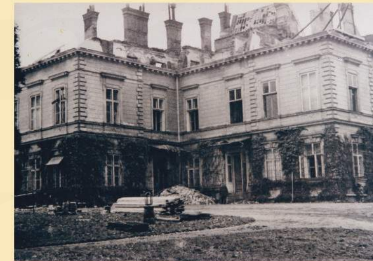
Práce na provizorním zastřešení. V pravém horním rohu lze spatřit konstrukci vrátku. Jaro 1945 (Foto ze soukromé sbírky Vladislava O.)
