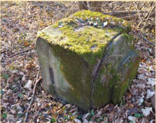
Pískovcový podstavec sloužil k podpěře sloupu tvořícího vstup do promenády (Foto Petr Bindač, rok 2021)
