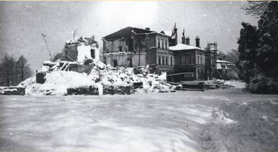
Demolice západního křídla a hlavního traktu zámku Solca. Konec roku 1947 (Foto SOKA Karviná)
