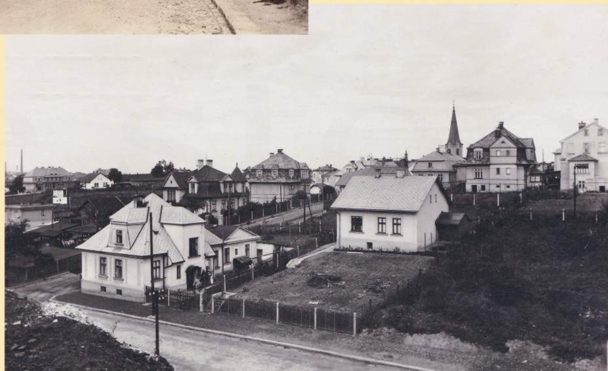
Pohled na vilovou čtvrť v Solci. V popředí dům č. p. 1460. V pozadí věž kostela sv. Jindřicha (Foto ze soukromé sbírky Zdeňka Janulka)
