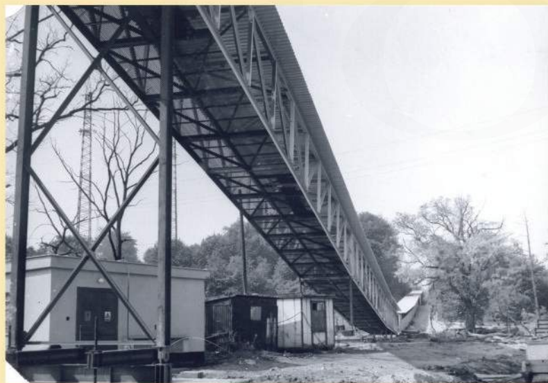
Uhelný dopravník. Pohled od dolu Darkov směrem k hrobce. Rok 1985 (Foto SOKA Karviná)
