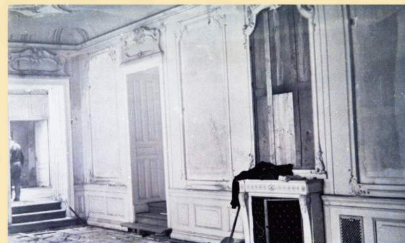
Požárem méně postižená část zámku (Foto z pozůstalosti F. Sikory)
