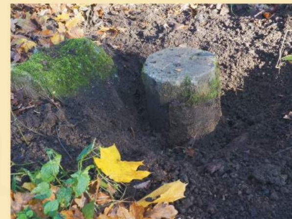
Patka sloužící k ukotvení dřevěného sloupku (Foto Erika Schweserová, rok 2020)
