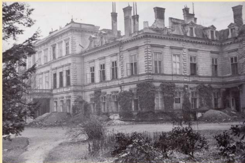
Severní strana zámku. Snímek zachycuje tři okna v prvním patře u balkónu – epicentrum požáru. Jaro 1945 (Foto ze soukromé sbírky Vladislava O.)
