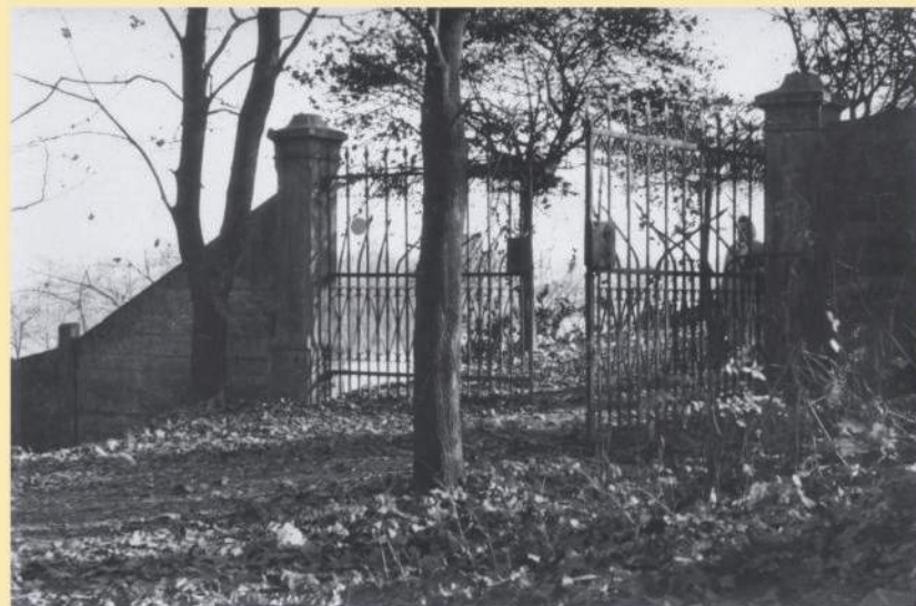
Východní brána nad hrobkou. Pohled z parku. Za povšimnutí stojí poničené zdobené brány, které bylo v pozdějších letech ulámáno a ukradeno. Rok 1957 (Foto Ing. Jan Válek)
