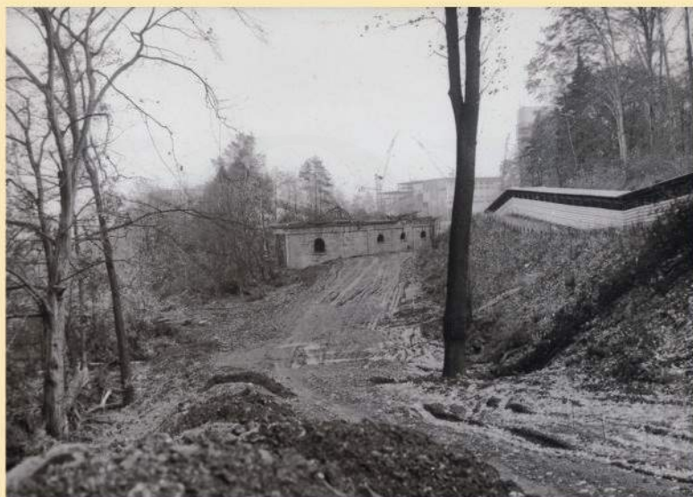
Uhelný dopravník byl postaven v těsné blízkosti hrobky. V pozadí snímku je zachycena výstavba úpravárenského závodu dolu Darkov. Rok 1985 (Foto SOKA Karviná)
