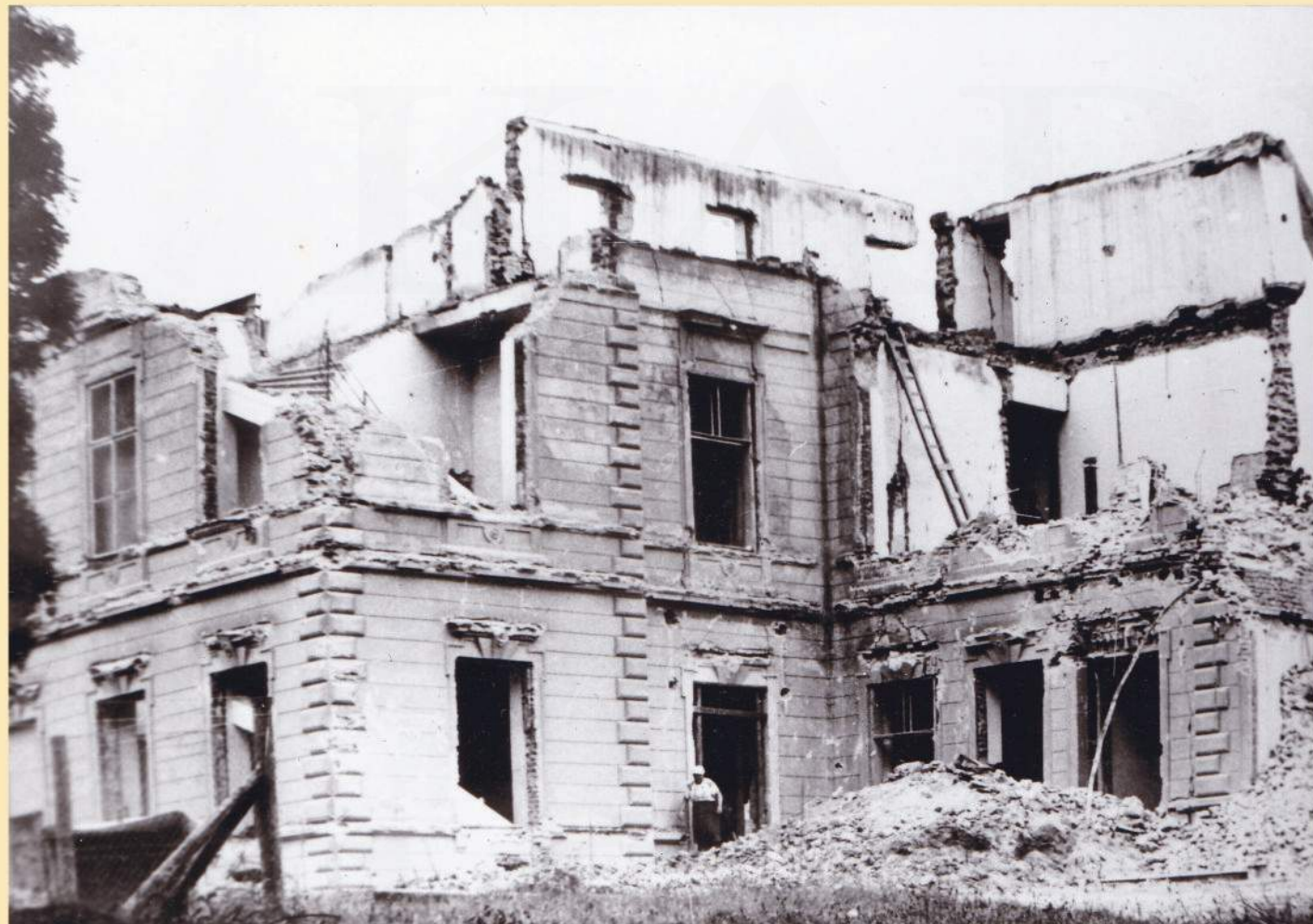
Demoliční práce v průběhu roku 1953. Snímek je velmi často označován jako demolice vyhořelé části zámku. Podařilo se nám však, dle detailů stavebních úprav provedených při adaptaci určit, že se jedná až o pozdější demolici Domu zdraví. (Foto ze soukromé sbírky Vladislava O.)
