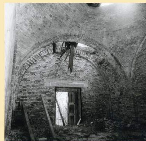
Snímek zachycující propad střechy (Foto HBZS Ostrava, Magistrát města Karviná)
