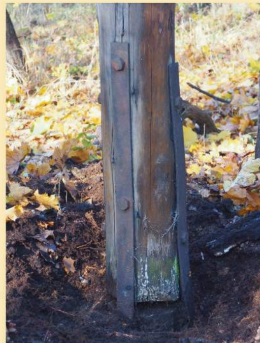
Detail ukotvení dřevěného sloupku (Foto Erika Schweserová, rok 2020)
