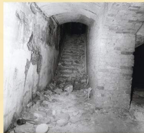
Stav schodiště vedoucí z krypty (Foto HBZS Ostrava, Magistrát města Karviná)
