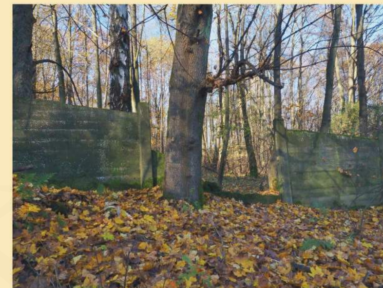
Betonové oplocení pod Východní bránou je místy ve stále dobrém stavu (Foto Petr Bindač, rok 2021)
