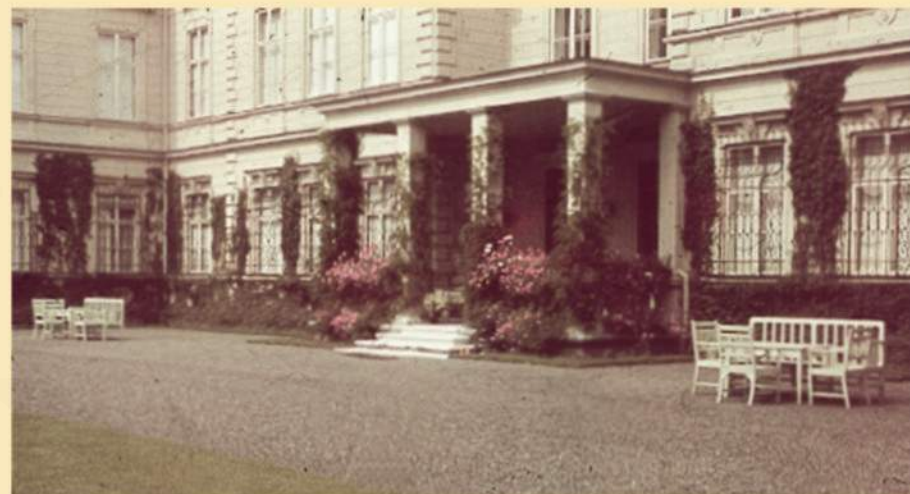
Jižní strana. Detail vstupu s již stavebně upravenou verandou (Foto ze soukromé sbírky Vladislava O.)
