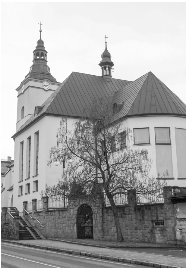
Jablunkovský kostel po přestavbě z počátku 30. let 20. stol., současný stav
