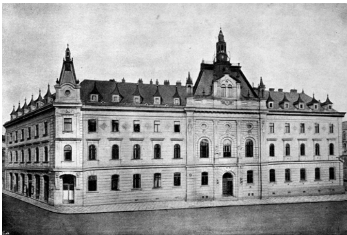
Nová budova Místecké spořitelny z roku 1898
