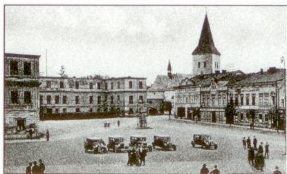
Kostel Povýšení sv. kříže s vyšší věží.
