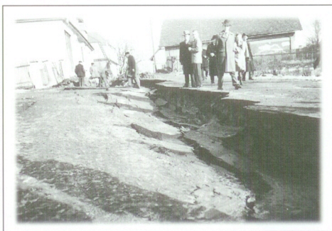
Vlivy poddolování: narušené zdivo domu a upadlá silnice.
