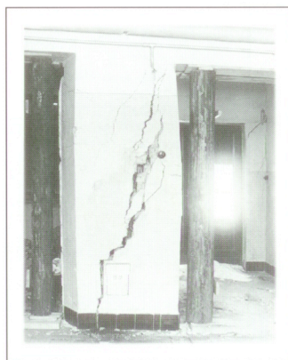
Vlivy poddolování: narušené zdivo domu a upadlá silnice.
