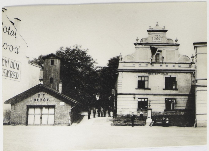
Stará radnice v Orlové s požární zbrojnicí.
