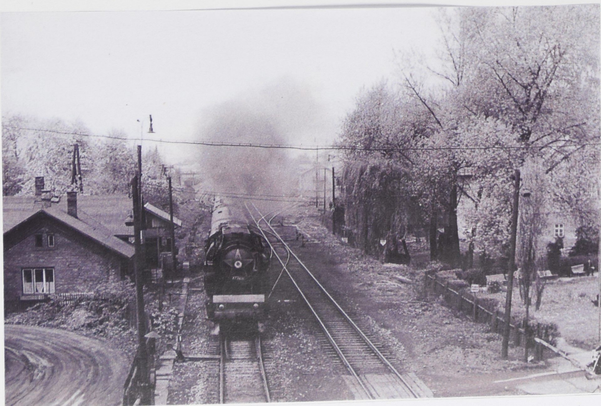
Vlaky jezdily přes Orlovou na Košicko-bohumínské dráze již od roku 1869, teprve na konci 19. století byla postavena budova orlovského železničního nádraží a zastavovaly zde projíždějící vlaky.
