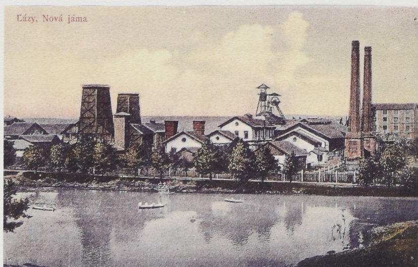
Důl Nová jáma (Neuschacht) v Lazích.
