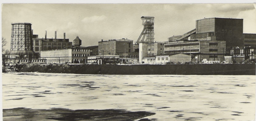
Nová jáma byla přejmenována na důl Antonín Zápotocký. Panoramatická pohlednice zachycuje chladicí věž, kotelnu, správní budovu, strojovnu, těžní věž, sklad a prádlo uhlí.
