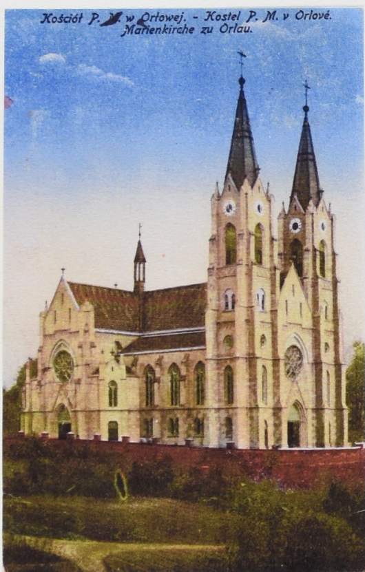
Pohled na katolický kostel postavený v letech 1904–1908 stavelem Martincem podle projektu bohumínského stavitele Bergera.
