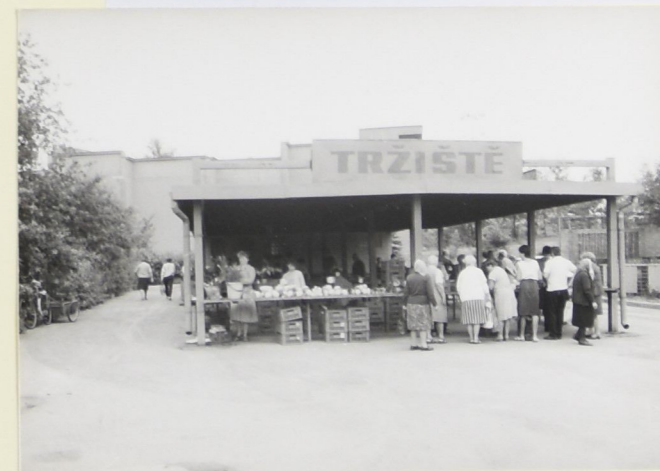
S přesunem obyvatelstva staré Orlové a Lazů na sídliště do Orlové-Lutyně nahradila již skomírající trhy městská tržnice.
