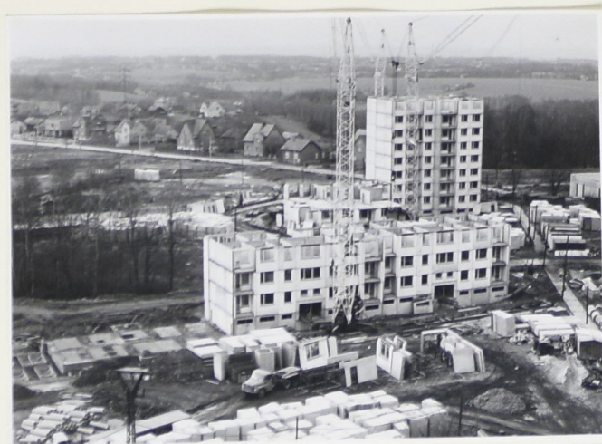
Průběh výstavby obytných domů o panelové konstrukci ve čtvrtém okrsku Orlová-Lutyně.
