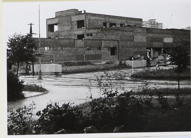
Rozestavěná budova obchodního domu Prior v roce 1980.
