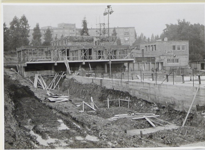
Stavba zimního stadionu v roce 1981.
