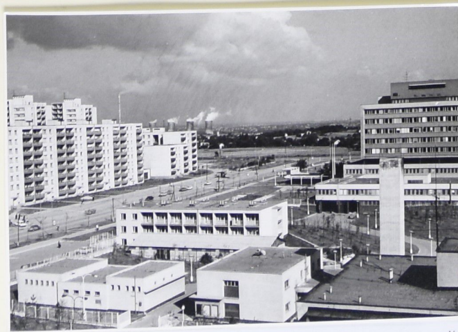
Pohled na nově postavené město s nemocnicí vpravo a v pozadí s chladičnými věžemi děčmarovické kamenouhelné elektrárny v roce 1980.
