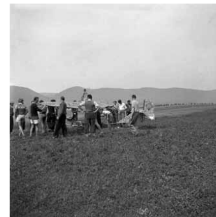
Přestalo přšet a na sestaveném kluzáku se kontrolují výztužná lanka, než se začne létat, jsme v Ořechách
