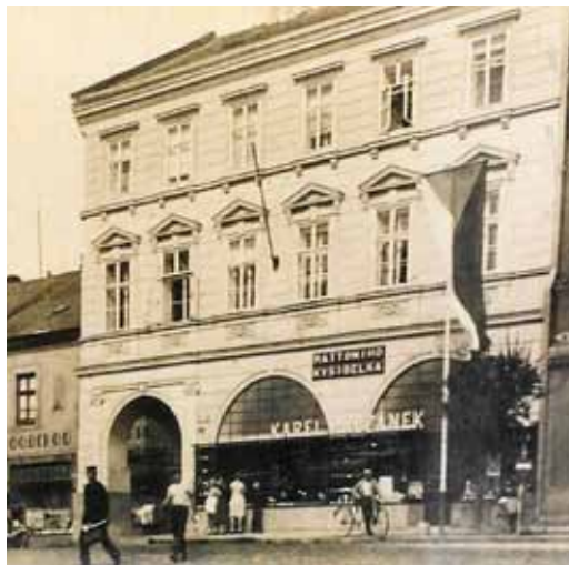
Přerov, dům č. p. 225 po roce 1936
