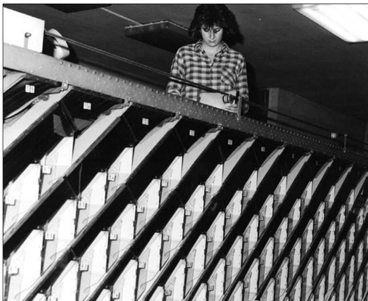
Obr. 30. Poloautomatický třídící stroj na listovní zásilky
