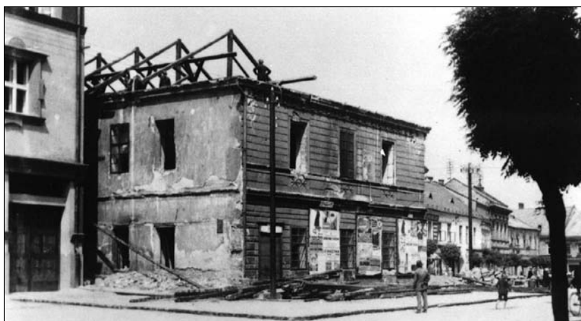
Obr. 16. Bourání staré školy pro postavení Městské spořitelny. Pošta je již v provozu
