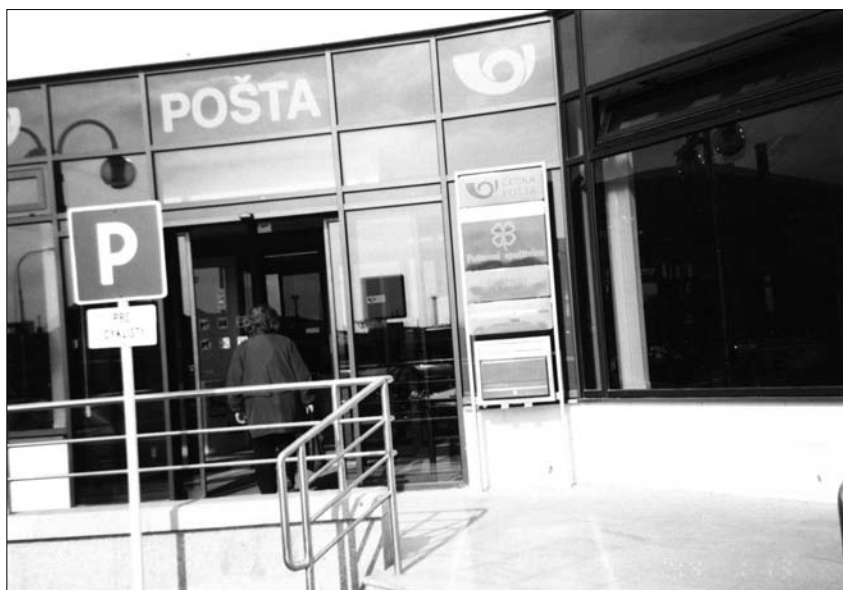
Obr. 32. Nová bezbariérová pošta pošta Přerov 1 u nádraží
