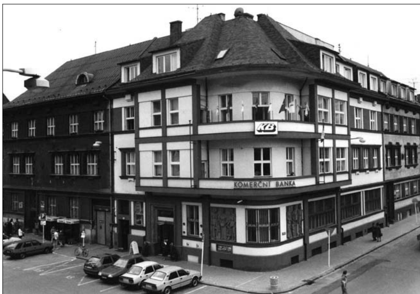
Obr. 18. Budova nové pošty ve městě v Kratochvílově ulici. Foto J. Čep
