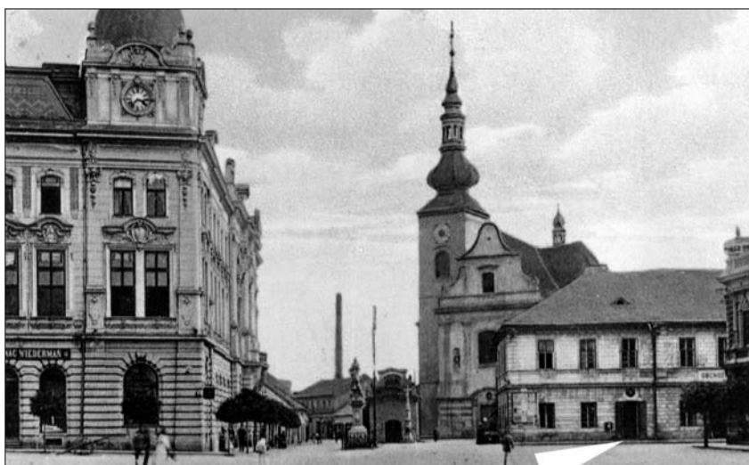
Obr. 12. Městská pošta ve škole ve Školní ulici
