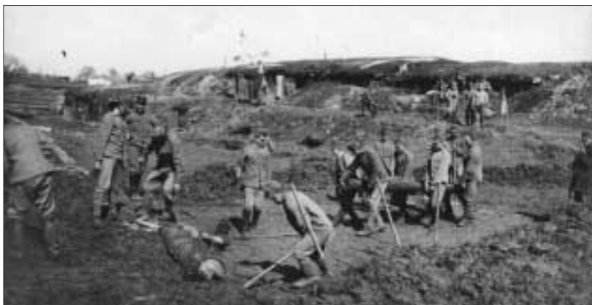
Oprava zablácených cest, Malín 1915.
