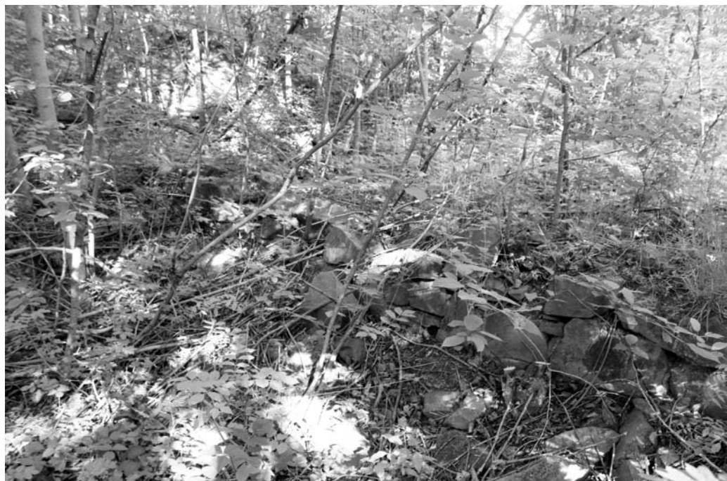
Základy drtiče (betonový nosník je na fotografii zcela vlevo).
