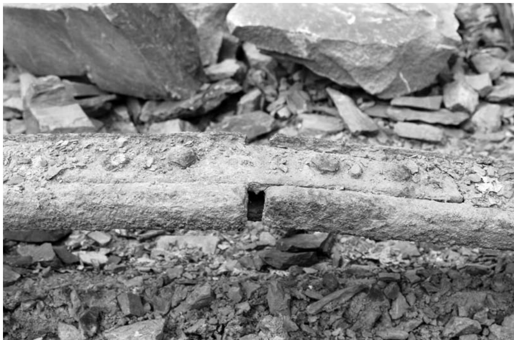
Detail spoje na kolejnici.
