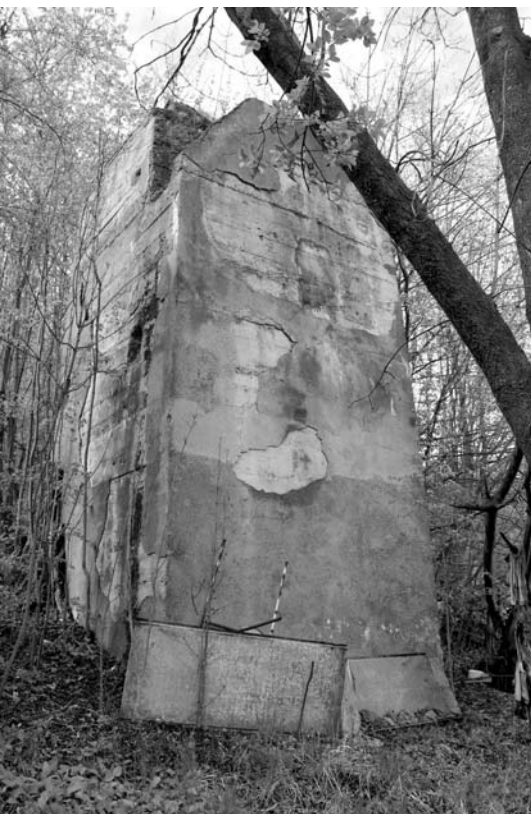
Betonový nosník drtiče.
