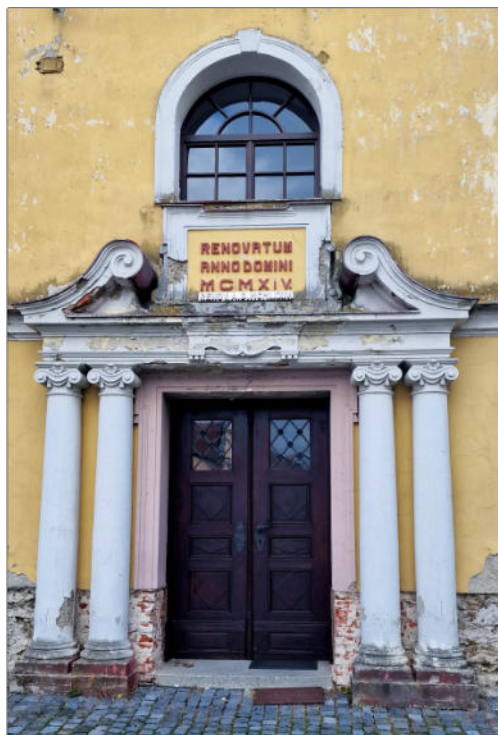
Vstupní portál (foto: autor)
