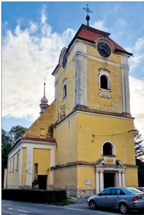
Kostel Nanebevzetí Panny Marie v Mostkovicích (foto: autor)
