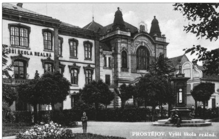
Nedatovaná pohlednice s budovou Vyšší reálné školy a novým templem (zdroj: Muzeum a galerie v Prostějově)
